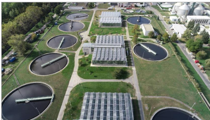
11. kép. A Dél-Pesti Szennyvíztisztító Telep (Fotó: FCSM) Photo 11. The South-Pest Wastewater Treatment Plant (Photo by FCSM)
