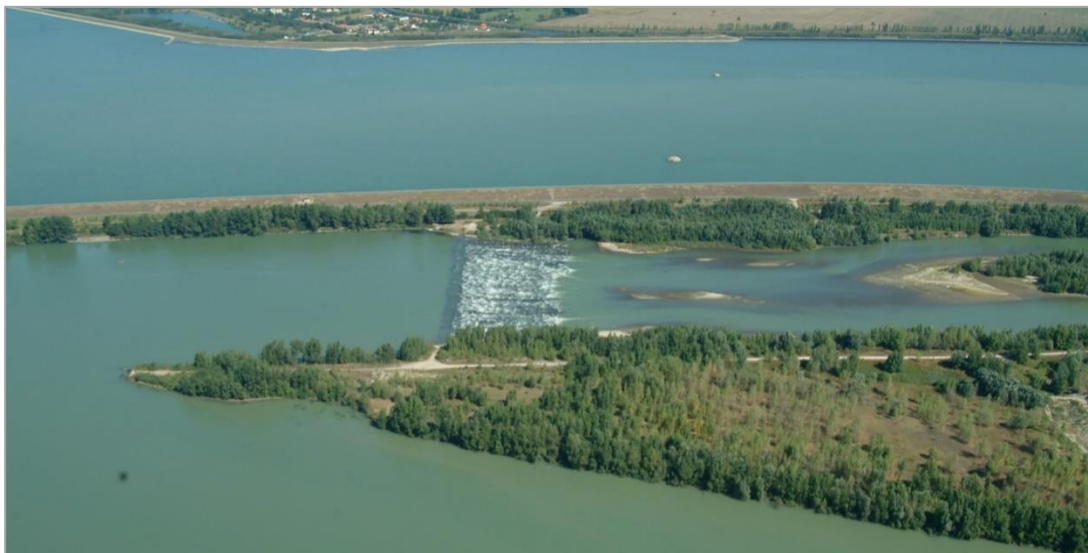
1. kép. A dunakiliti fenékküszöb háttérben az üzemvízcsatornával (Fotó: Kertész) Photo 1. Bottom sill at Dunakiliti with the diversion canal in the background (Photo: Kertész)
