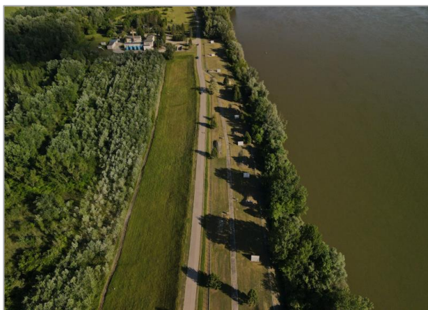
2. ábra. A bajai parti szűrésű kútsor és a vízmű Figure 2. The riverbank filtration wells and the water treatment plant of Baja
