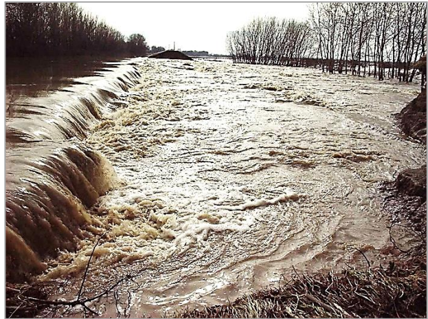
6. kép. Bukóél-szerű töltésmaradvány a tiszai szakadásnál (Fotó: FETIVIZIG)
