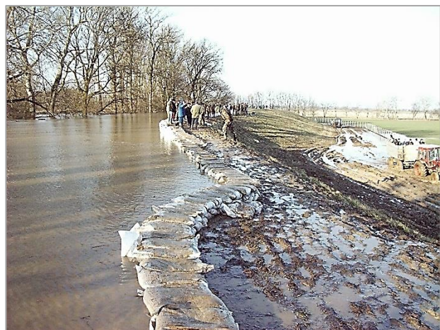
1. kép. Vízet tartó nyúlgát a Felső-Tiszán, Tivadar térségében (2001. március 6.) (Fotó: Magyar György) Picture 1. Emergency dike holding high water in the Tivadar area of the Upper Tisza (6 th March 2001) (Photo: György Magyar)
