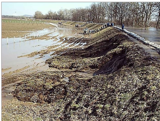
2. kép. Nyúlgátépítés Tarpa és Tivadar között (Fotó: FETIVIZIG)
