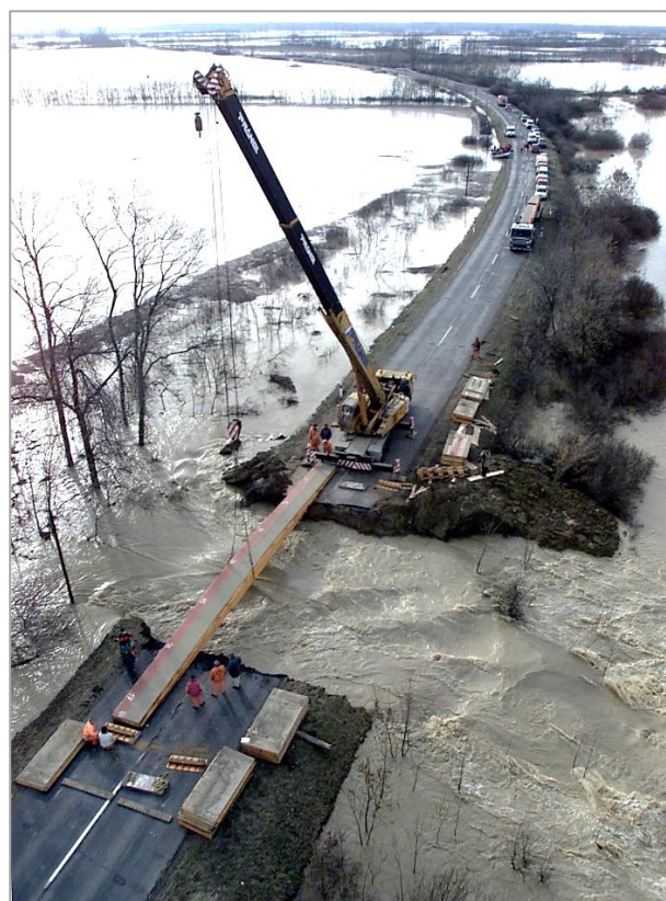
9. kép. Ideiglenes hid építése a 41. sz. főút átvágásának áthidalására (Fotó: FETIVIZIG)
