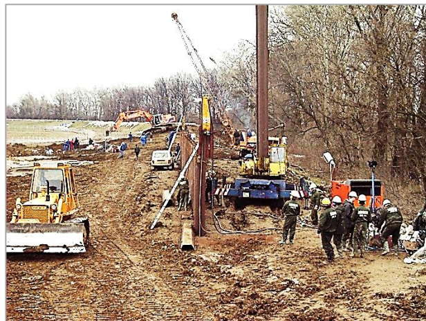
7. kép. A tivadari gátszakadás helyreállítása (Fotó: Magyar György)
