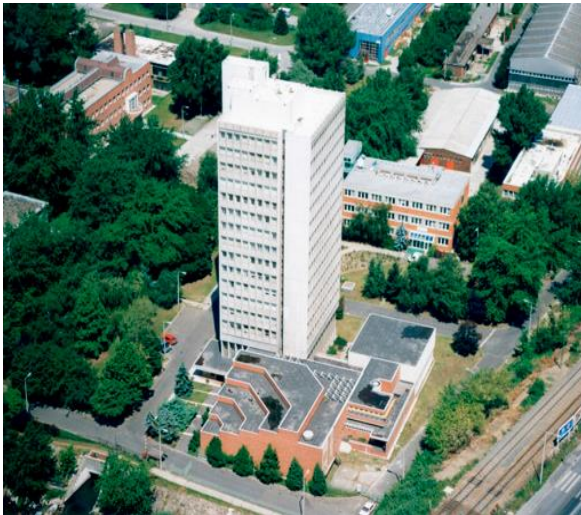
A Mühlbacher István és Demény Tamás által tervezett, s 1976-ban átadott toronyház a VITUKI központi telephelyén (Budapest, IX. ker. Kvassay Jenő út 1.)
