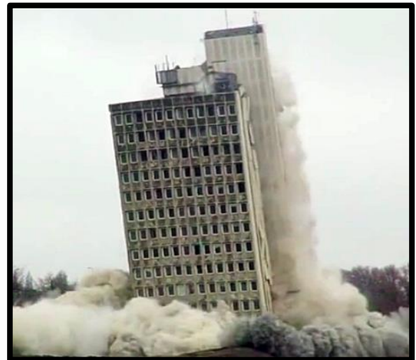
A tragikus pillanat. A VITUKI fizikai megsemmisítése 2020. december 10-én a toronyépület ledöntésével fejeződött be.
