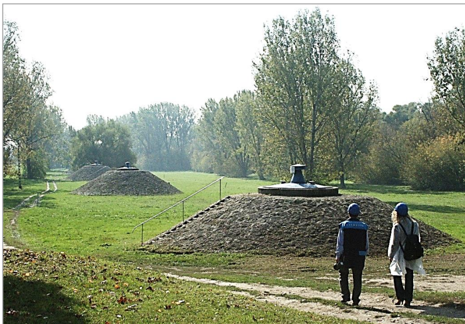
Illusztráció a cikkhez. Parti szűrősű kutak a Szentendrei-szigeten (Fotó: Bajomi Bálint)
