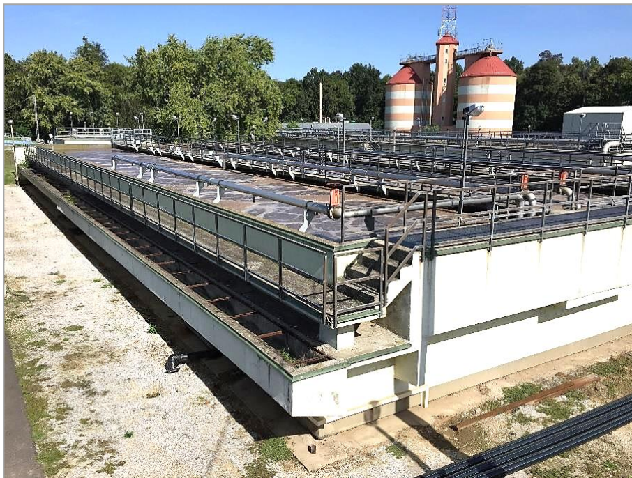
Illusztráció a cikkhez. A nyíregyházi szennyvíztisztító telep biológiai fokozata (a háttérben a rothasztó berendezés) (Fotó a Szerzőktől)
