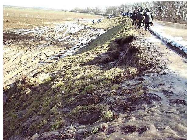
6. kép. A tivadari megnyílás helye néhány órával a gátszakadás előtt Photo 6. The location of the breaching in Tivadar a few hours before the dike failure
