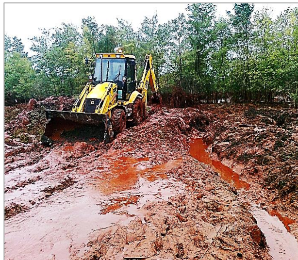
11. kép. Szennyezett terület mentesítése markolóval Photo 11. Clearing contaminated area with a grapple
