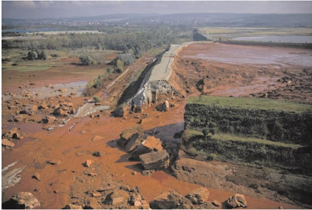
1. kép. A kolontári gátszakadás – 2010. október 4 Photo 1. The dam failure in Kolontár – 4 th October 2010
