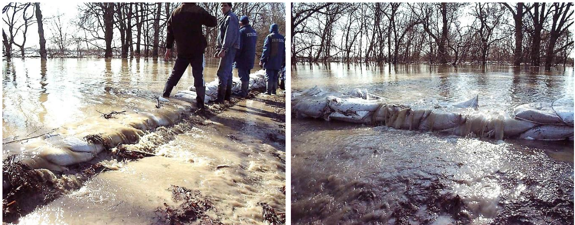
3. és 4. kép. Helyenként a nyúlgáton folyt át a víz, ez elősegítette a mentett oldal eláztatását Photo 3 and 4. Water flowed over the emergency heightening, which helped to soak the protected side
