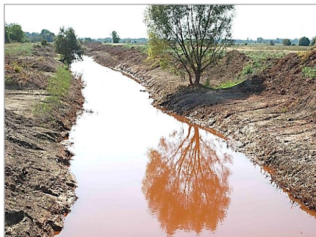
12. kép. Megkötött előtér és rézsű Photo 12. Excavated foreground and slope
