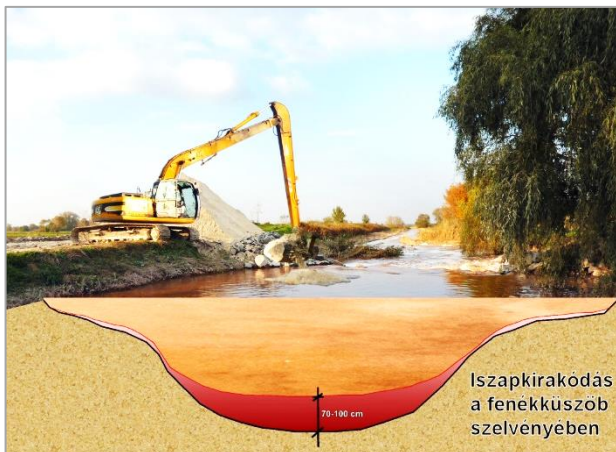
8. ábra. Iszapkirkodás a fenékküszöb szelvényében a Marcalon Figure 8. Sludge deposition in the bottom sill section of the Marcal River
