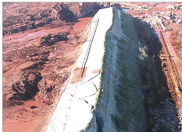
2. kép. A kolontári X. kazetta megmozdult gátszakasza Photo 2. The moved dam section of the X. cassette in Kolontár
