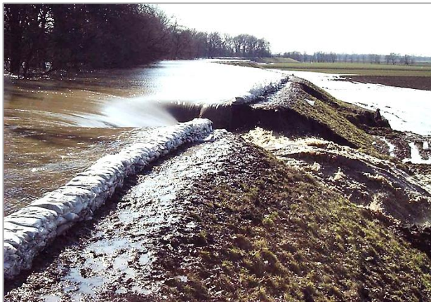
7. kép A tarpai gátszakadás emblemikus fényképe Photo 7. An emblematic photograph of the Tarpa dike failure
