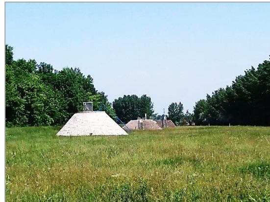
2. kép. A vízbázisra telepített parti szűrésű csőkutak (Forrás: Baki Zoltán, BÁCSVÍZ Zrt. 2018.) Photo 2. Bank-filtered water wells installed on the subsurface water resources (Zoltán Baki, BÁCSVÍZ Zrt. 2018)
