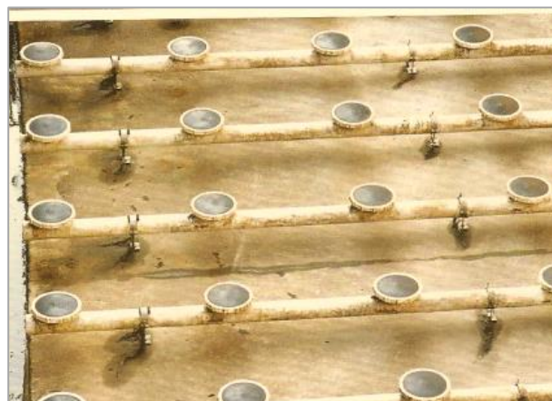
11. ábra. Saniter típusú mélylevegőztető Figure 11. Saniter type deep aerator
