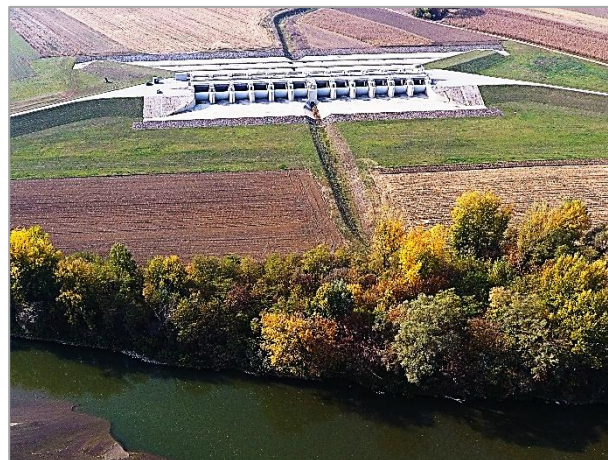
7. kép. A Szamos-Kraszna közti tározó feltöltő műtárgya Tunyogmatolcsnál, madártávlatból (Forrás: Felső-Tisza-vidéki Vízügyi Történelmi Gyűjtemény adattára, FETIVIZIG, Nyíregyháza)
