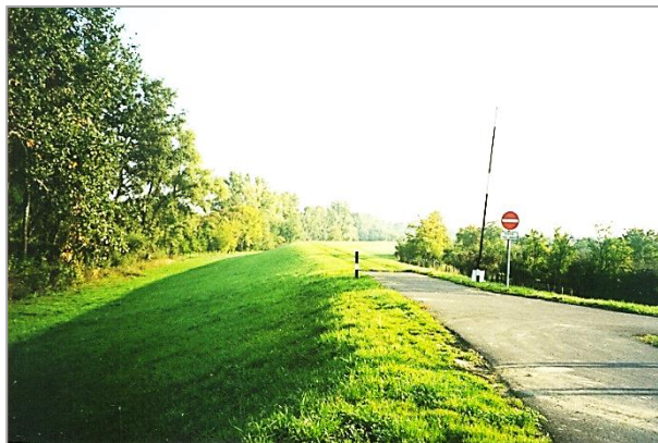
6. kép. A Szamos fejlesztett töltése (Forrás: Felső-Tisza-vidéki Vízügyi Történeli Gyűjtemény adattára, FETIVIZIG, Nyíregyháza)
