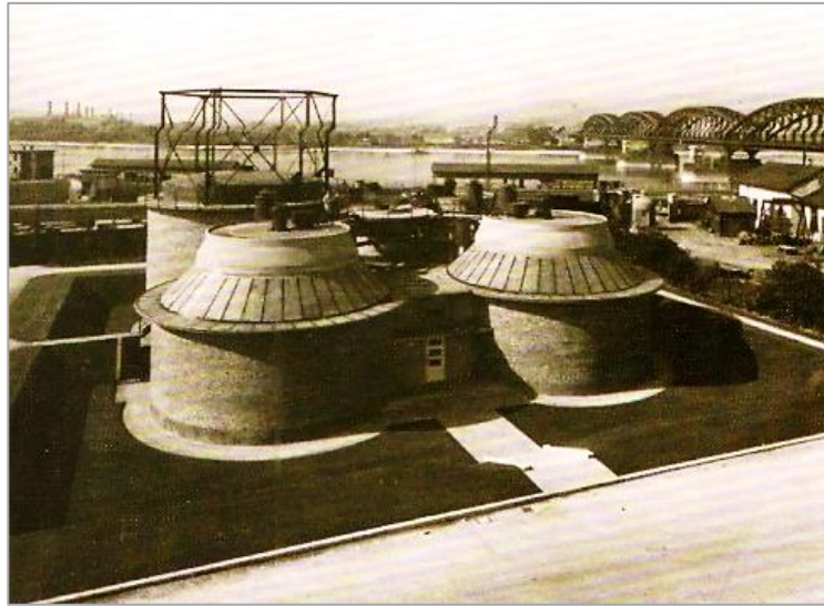
3. ábra. A rácscsemét rothasztók kialakítása (Garami és társai 1972) Figure 3. Formation of screenings digesters (Garami et. al 1972)
