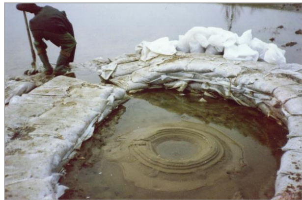
1. kép. Az 1998. évi dombrádi buzgár körülzárása és a kimosott anyag kúpja a vízszint csökkenése után
