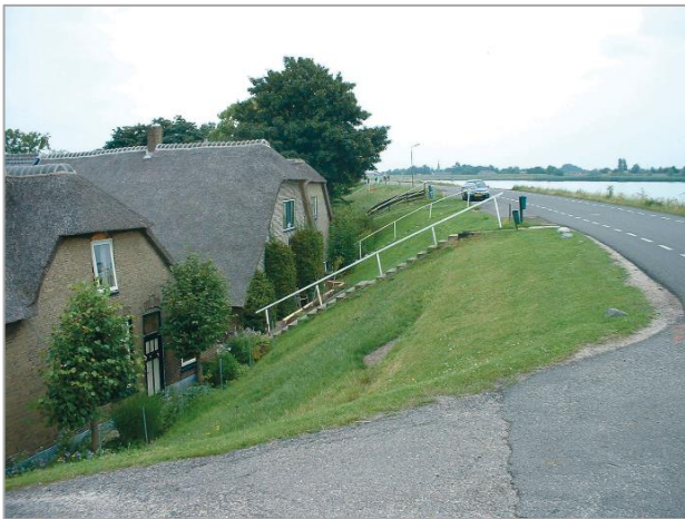
6. kép. Több ezer házra a gát ráépült a mentett oldali erősítések következtében
