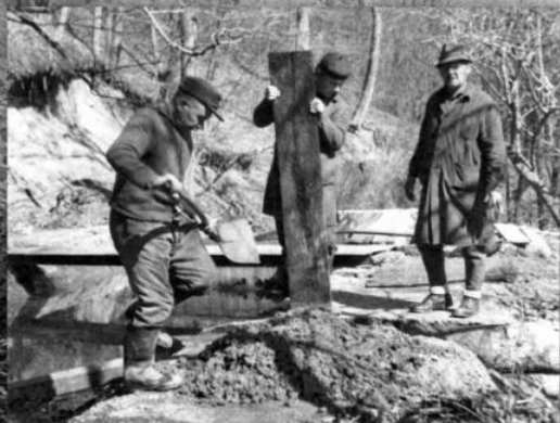
Munkálatok a vízkivételi műnél
