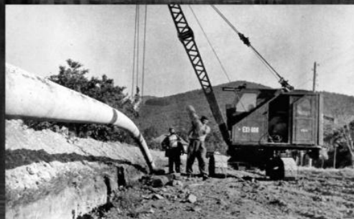
Szilvásváradtól-Borsodnádásdig DN 300-as fővezeték építése
