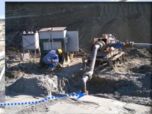
IDP centrifugál szivattyú, szívó és nyomóág
