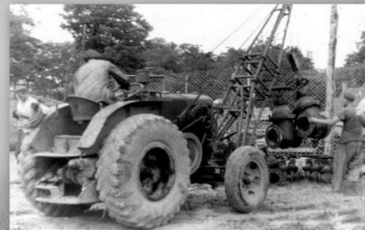
Elzáró szerelvények szállítása
