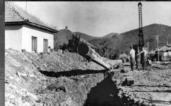
Szilvásváradtól-Borsodnádásdig DN 300-as fővezeték építése
