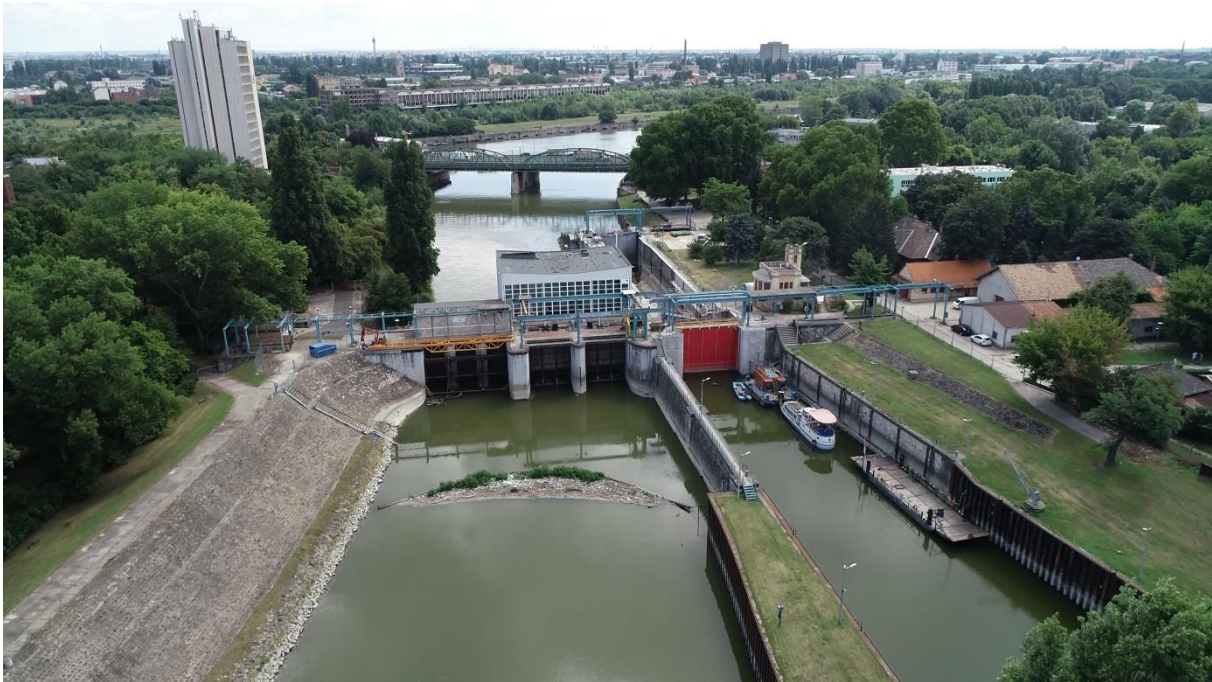
2. kép: A Kvassay-vízlépcső műtárgycsoportjának felvízi oldali látképe
