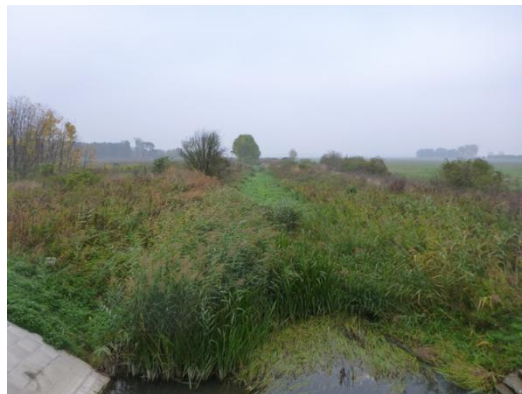
11. sz. kép: A Markósaroki duzzasztó alvizének rehabilitációt követő erős benőttsége (Répcse)
