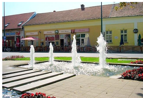
25. kép Az átépített Bodoki szökőkút
