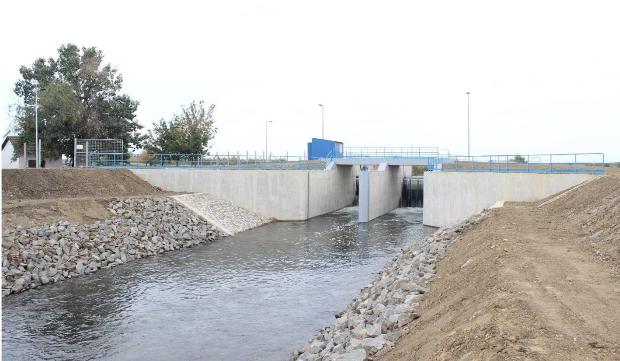
12. ábra. A Bakonszegi vízleadó műtárgy
