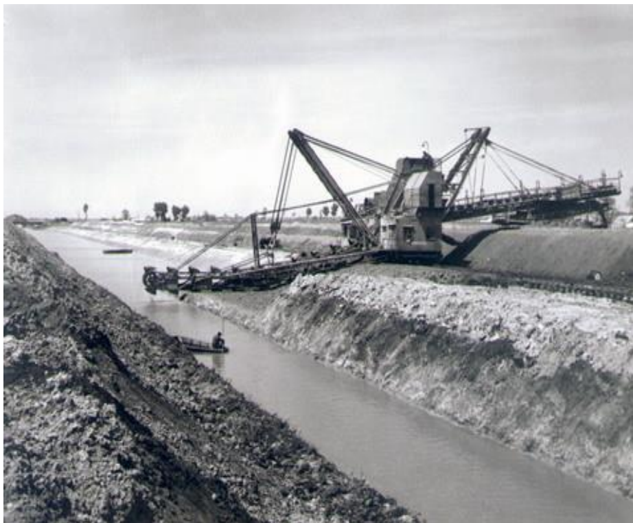
2. ábra. A Keleti-főcsatorna medrének fölmunkáját végző kotrógép
