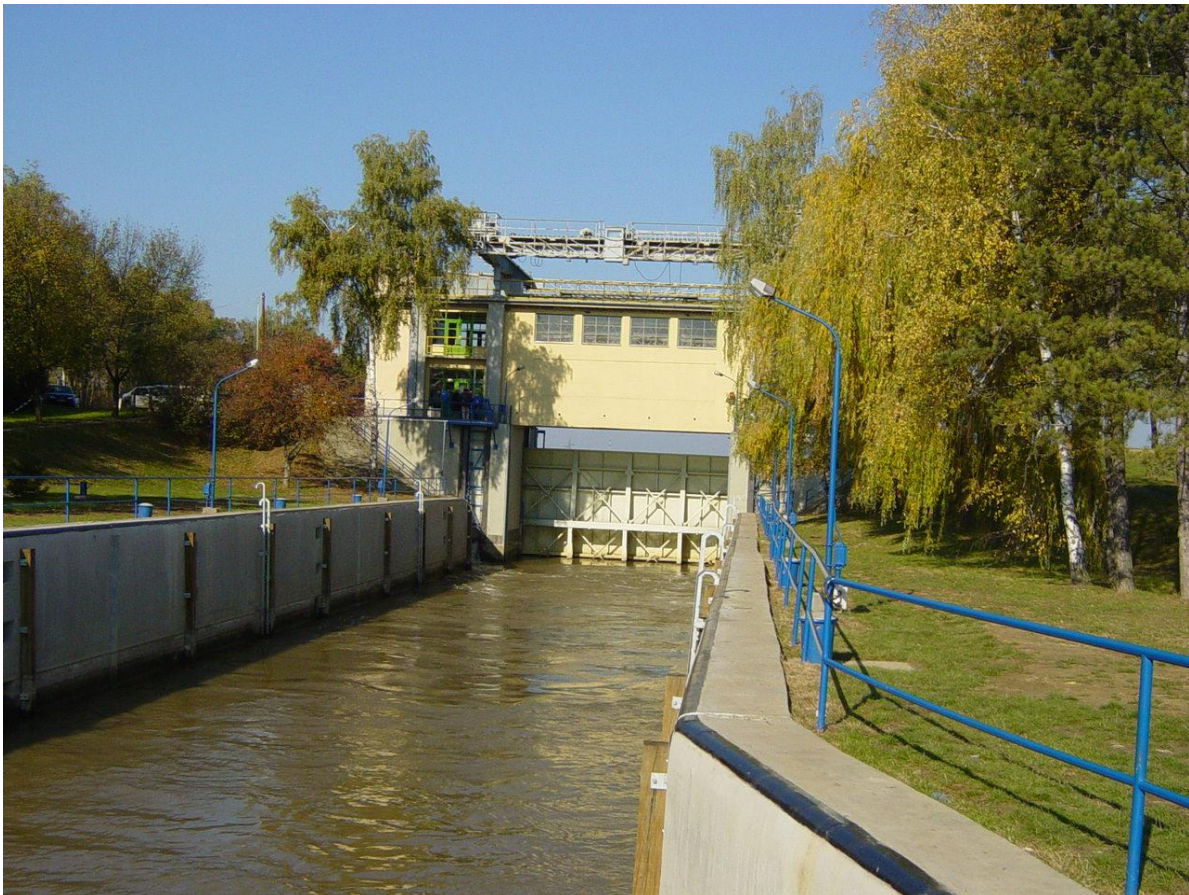
7. ábra. A Keleti-főcsatorna felújított beeresztő zsilipje
