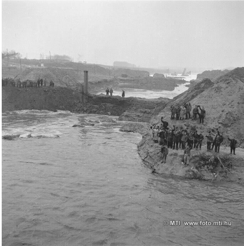
1. ábra. A munkálatok kezdete
