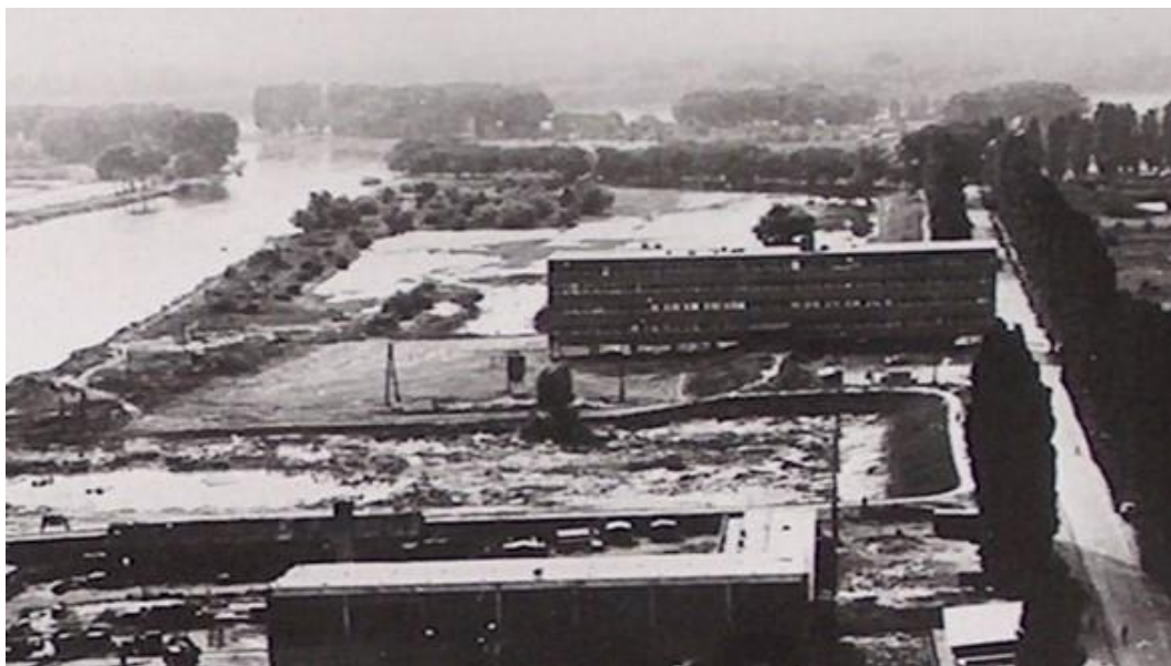
2. kép. Épül a Felsőfokú Vízgazdálkodási Technikum oktatási épülete (1965)
