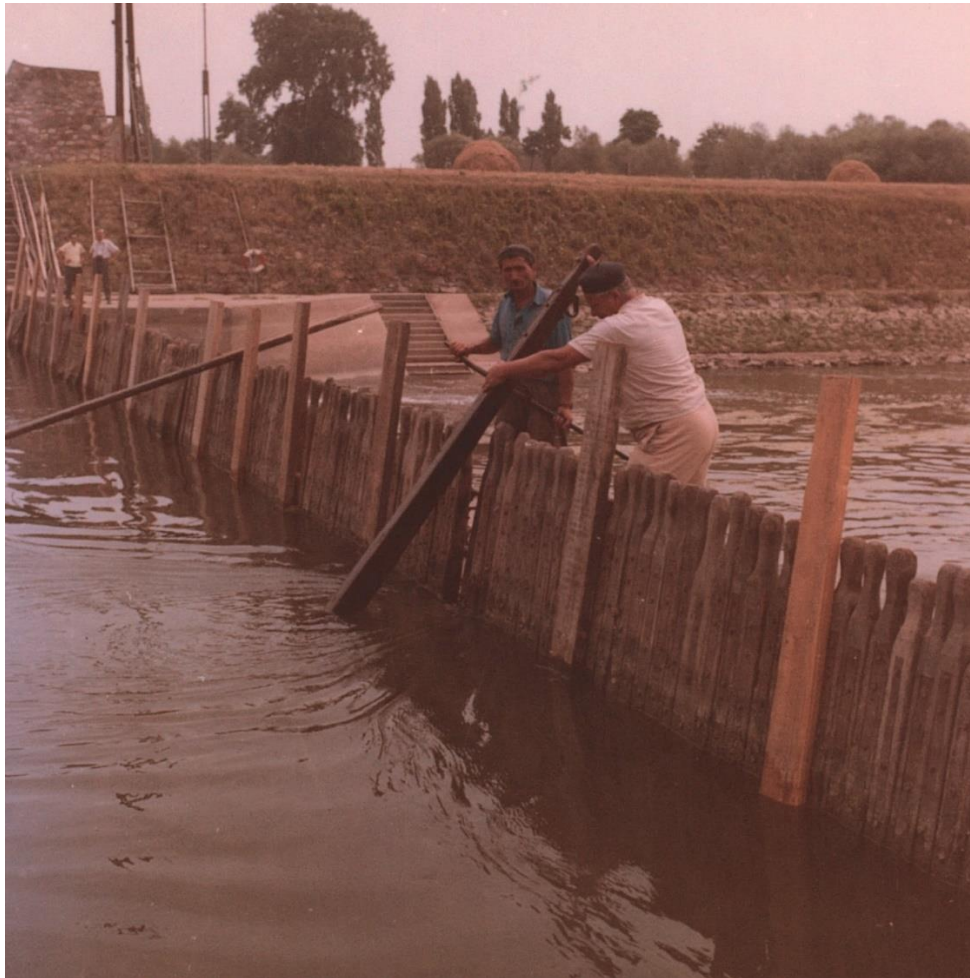
1. kép. A duzzasztó tűk behelyezése
