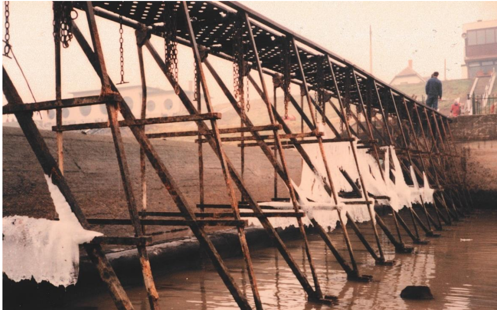
2. kép. A felállított keretek az elhelyezett hídlemezekkel
