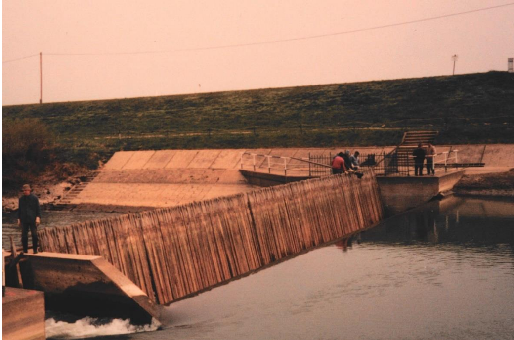
3. kép. A felállított tűs gát képe a felvíz felől
