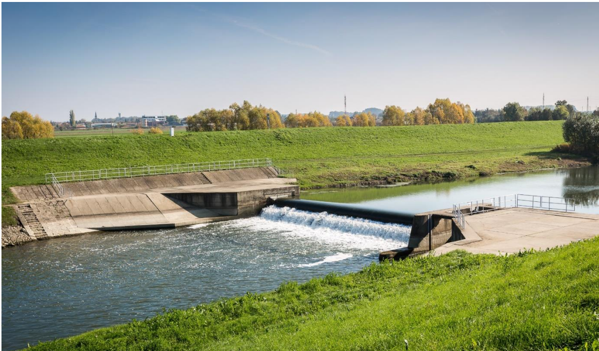
5. kép. A Gyulai duzzasztómű tömlős gátja
