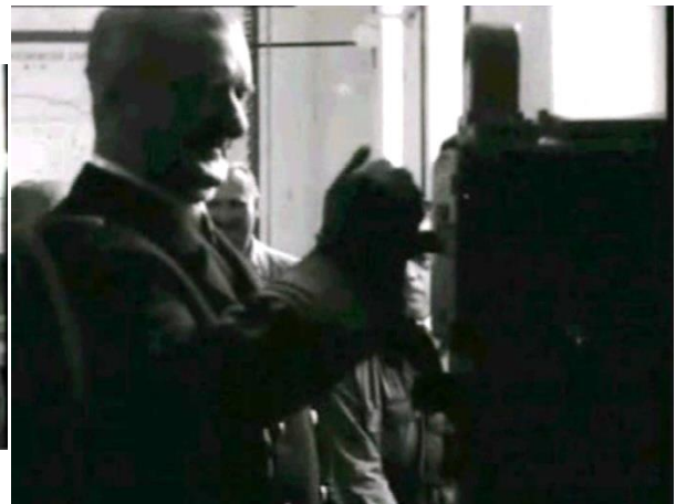
6. kép. A Kormányzó üzembe helyezi a szivattyúkat (Forrás: Magyar Világhíradó 853. adása)
