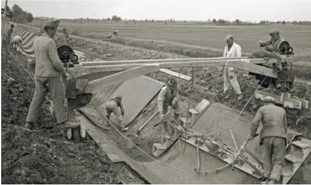
1. kép. Egyik elsőrendű mellékcsatorna kivitelezési munkái (Rubicon 28. évf. 5. szám)
