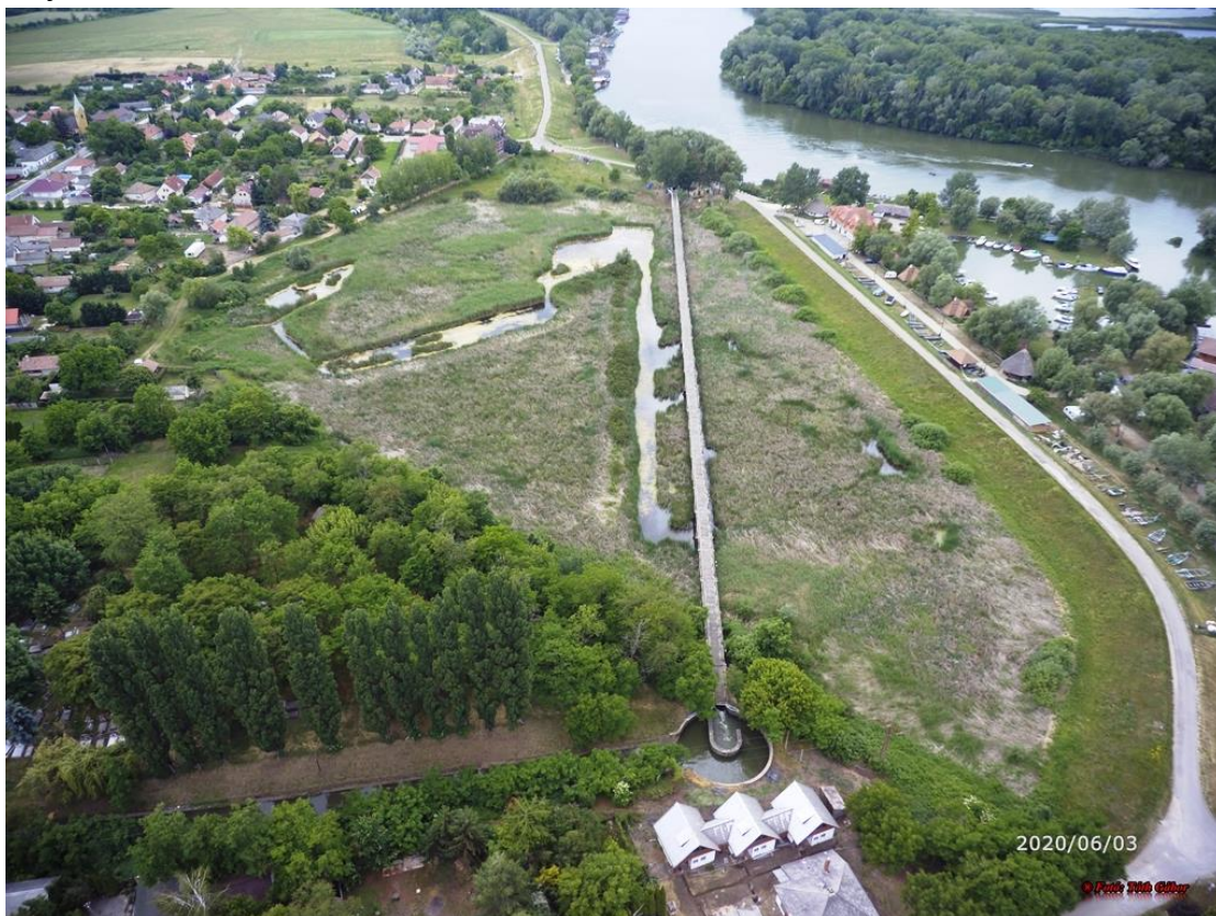
13. kép. A csatornahíd és a csillapító medence látképe (Fotó: Tóth Gábor, 2020)
