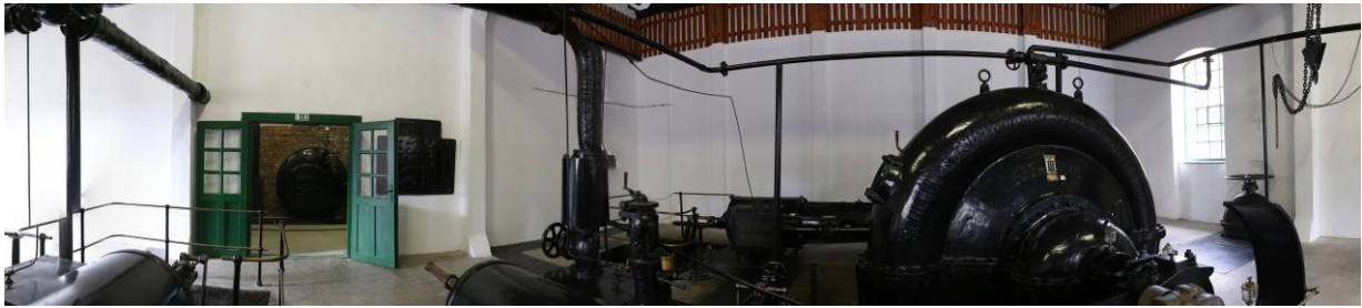
SCHLICK-féle szivattyú, háttérben a kazánnal
