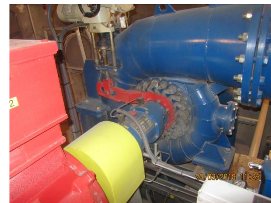
Francis turbina 650 l/s - 192 kw fölös vízmennyiség levezetése)
