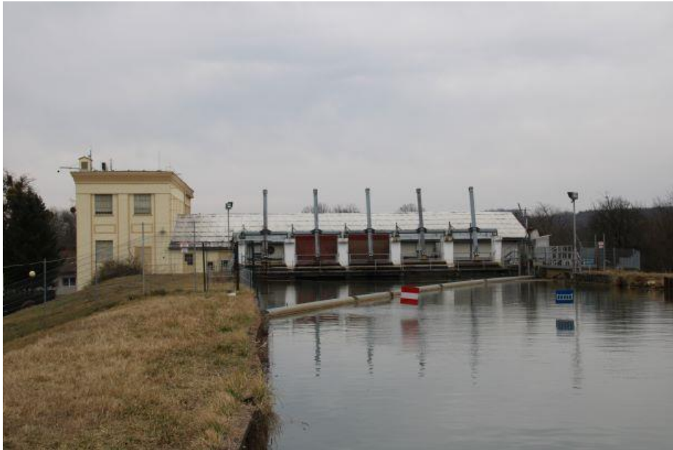
11. fénykép: Az erőműtelep felvízi oldala
