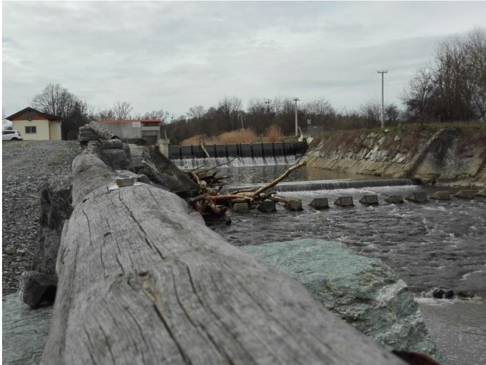
7. fénykép: Alvízi beton utófenék az új duzzasztómű alatt
