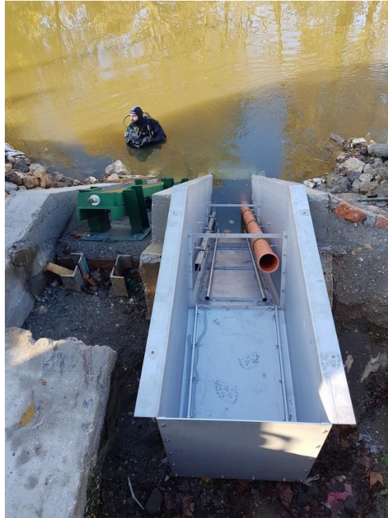
1. fénykép: A műszercsatorna beépítése
