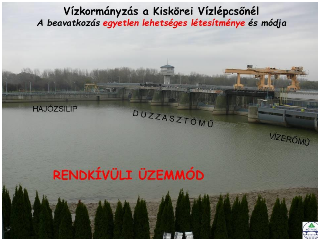
3. ábra. A vízkezelés nagyműtárgya
