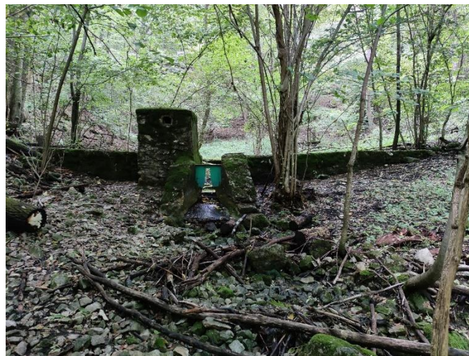
1. fénykép. A Lófej-forrás mérőműtárgya (saját fotó)
