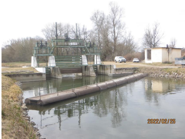
2. kép. Duna-völgyi-főcsatorna – Keceli duzzasztó
