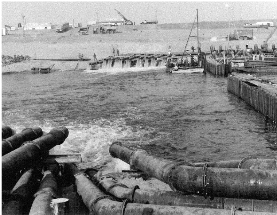
8. fénykép: A szivattyús próbaüzem sikeres volt.
