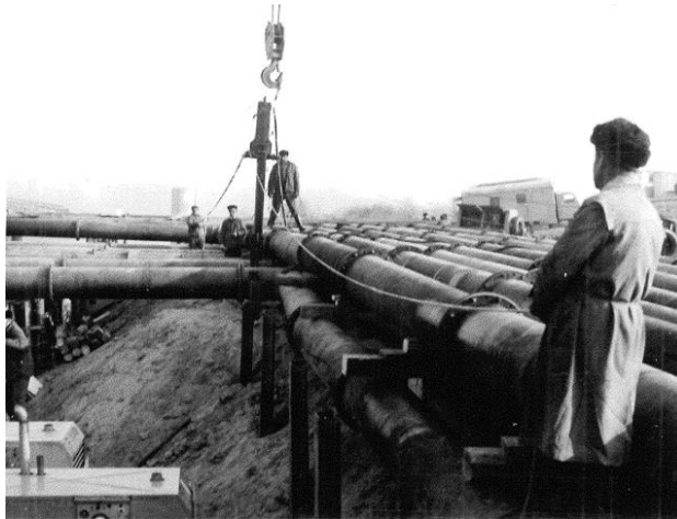
6. fénykép: Tömörítő cölöpök leverése.
