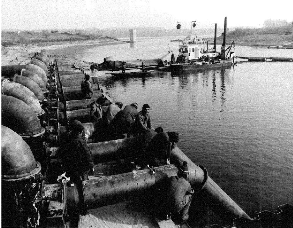
5. fénykép: A szivattyúcsövek szerelése és visszabontása az északi oldalon. Háttérben a Jelky András szívókotró hajó.
