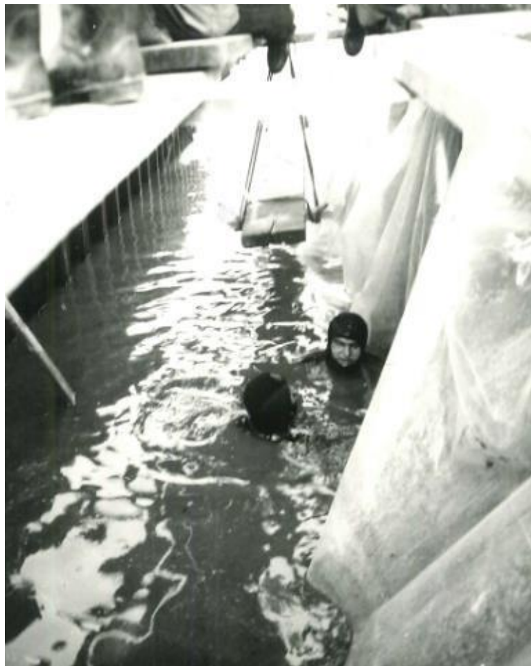
1. fénykép: Búvárok a szádfal sor fólia takarását végzik.
