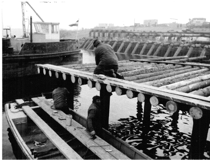
9. fénykép: Cölöp szivattyúállások készítése.
