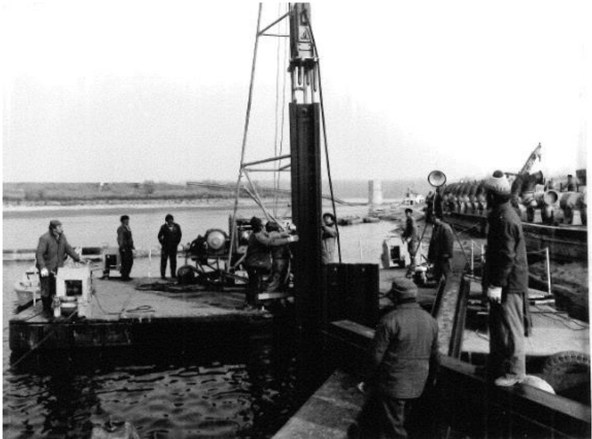
10. fénykép: TEP 401 szádlemez-verőgép kis-hídmezőre szerelt Zulce verőállványon, CS-2-M szádlemez lehajtására beállítva.
