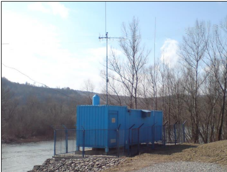
2. ábra. A Tisza – Técső (UA) vízrajzi távmérő állomás
