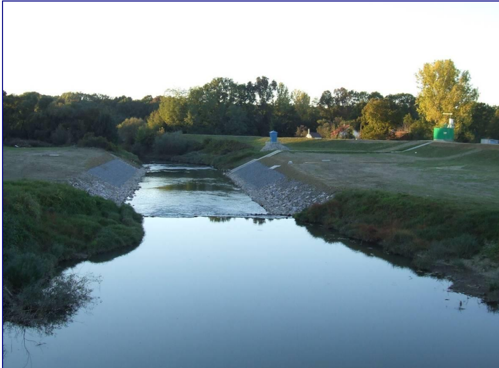
5. ábra. A Túr-garbolci ultrahangos vízhozammérő állomás (FETIVIZIG, 2017)
