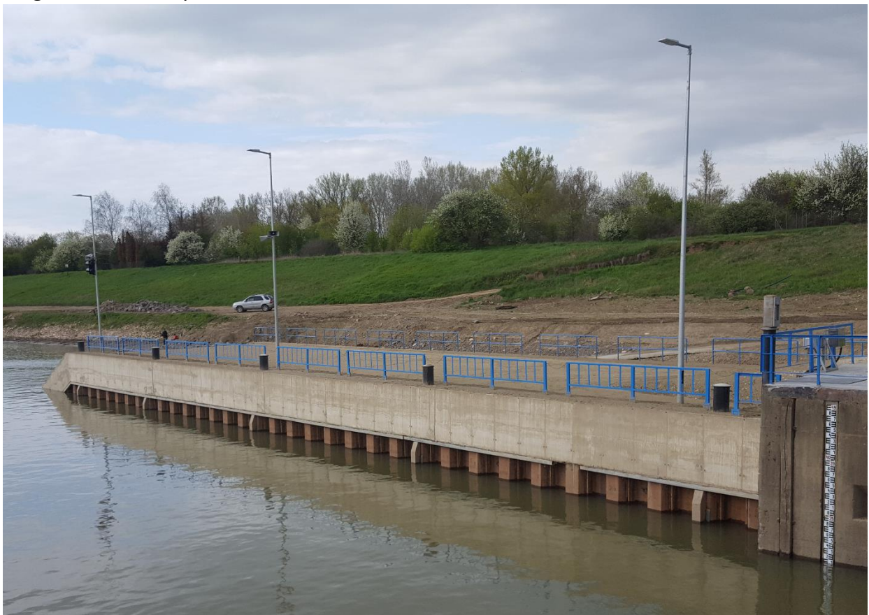
5. ábra Megépült alvízi vezetőmű (2023.04-i állapot)
