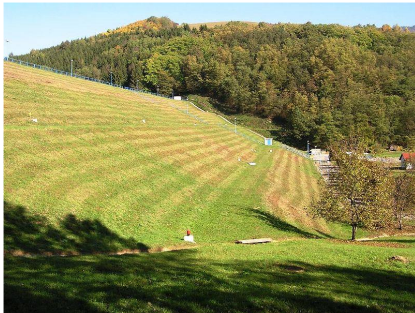
8. Ábra. A mentett oldali rézsú, a körömpontban a szivárgóvizet gyűjtő és elvezető övárókkal
