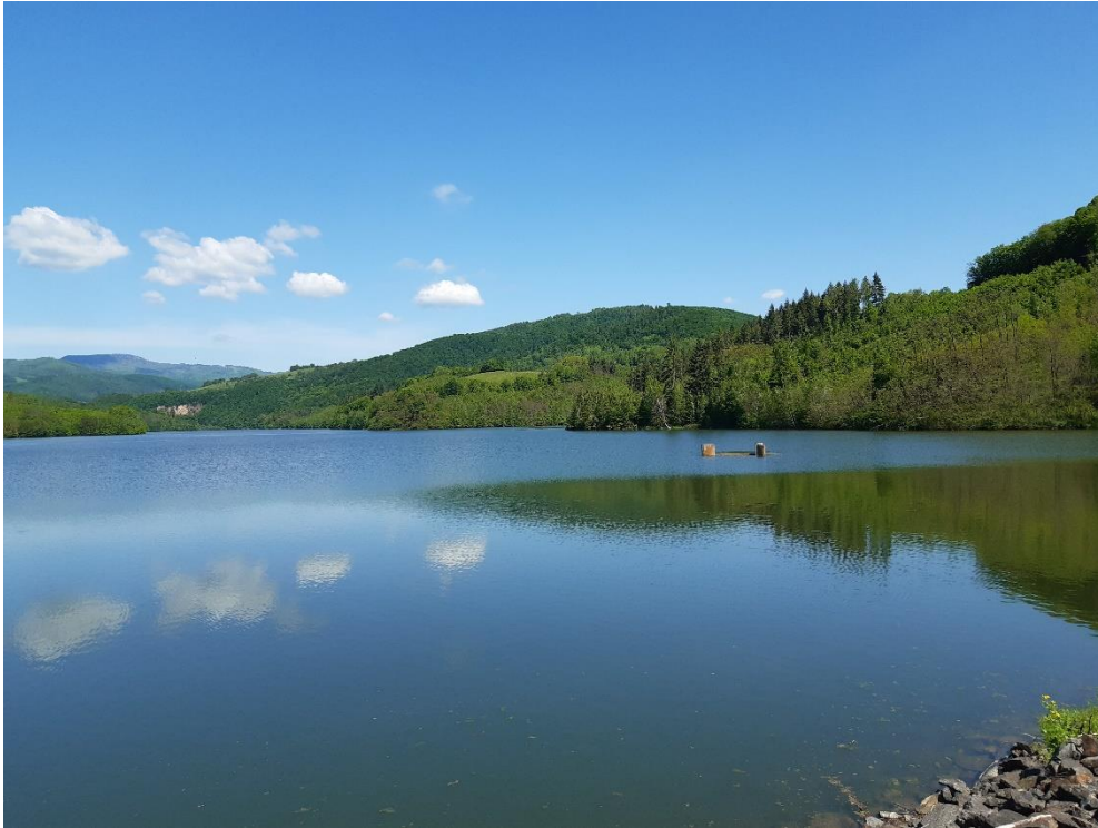
12. Ábra. A tározó a gáttest felől, a kép baloldalának harmadában az egyesített műtárgy, nagycsapadék után
