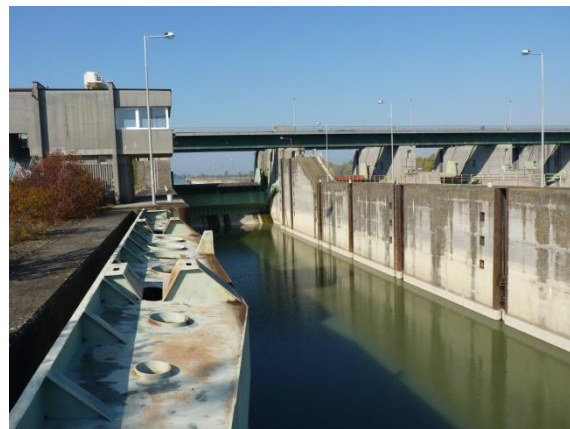
2. ábra. Dunakiliti segédhajózsilip nyitott támkapu
