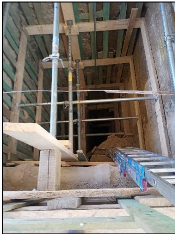
2. kép. Bal oldalon a kutatóárok teljes keresztmetszetében, jobb oldalon a dúcolt agyag oldalfal
