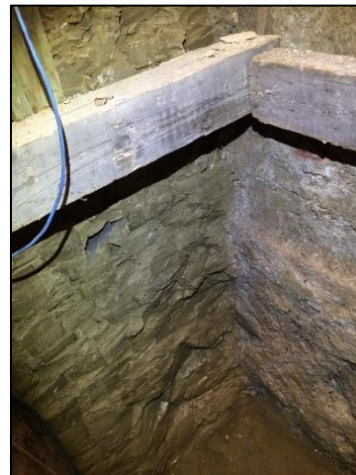
2. kép. Bal oldalon a kutatóárok teljes keresztmetszetében, jobb oldalon a dúcolt agyag oldalfal
