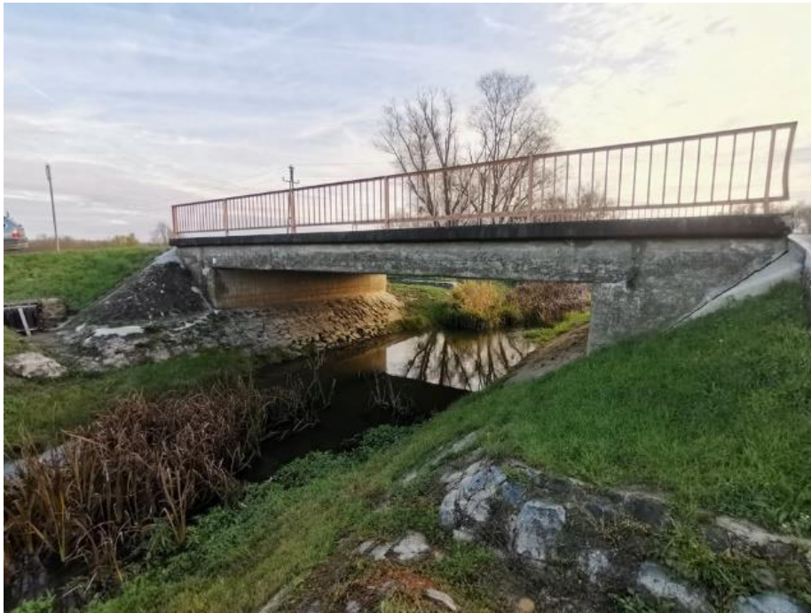
2. kép. 6811 sz. közúti híd alvízi oldal békeidőben
