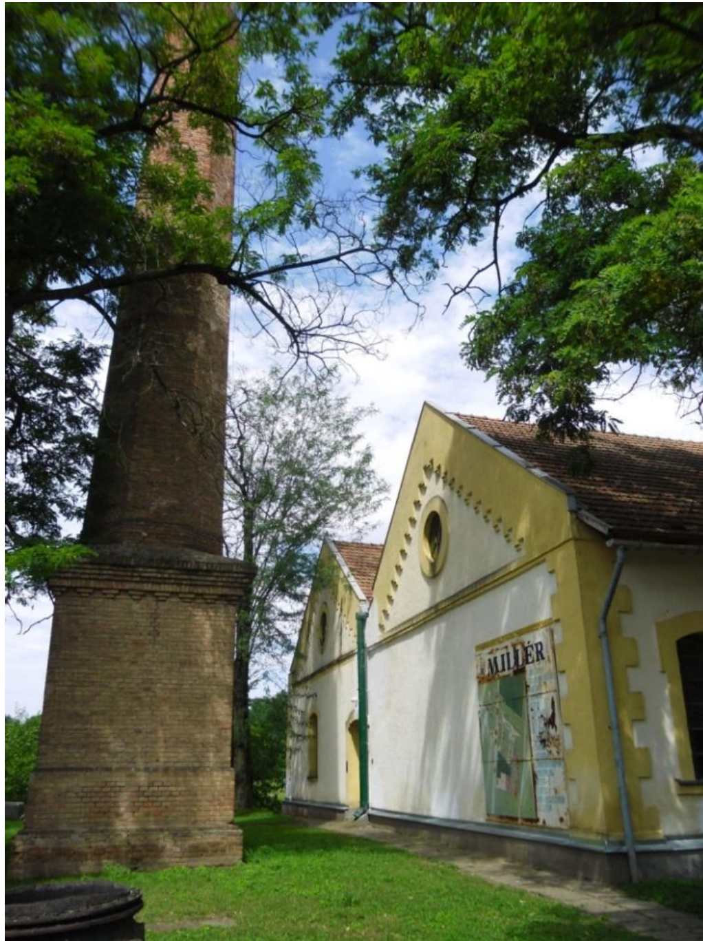
4. kép: Milléri szivattyútelep/saját fotó
