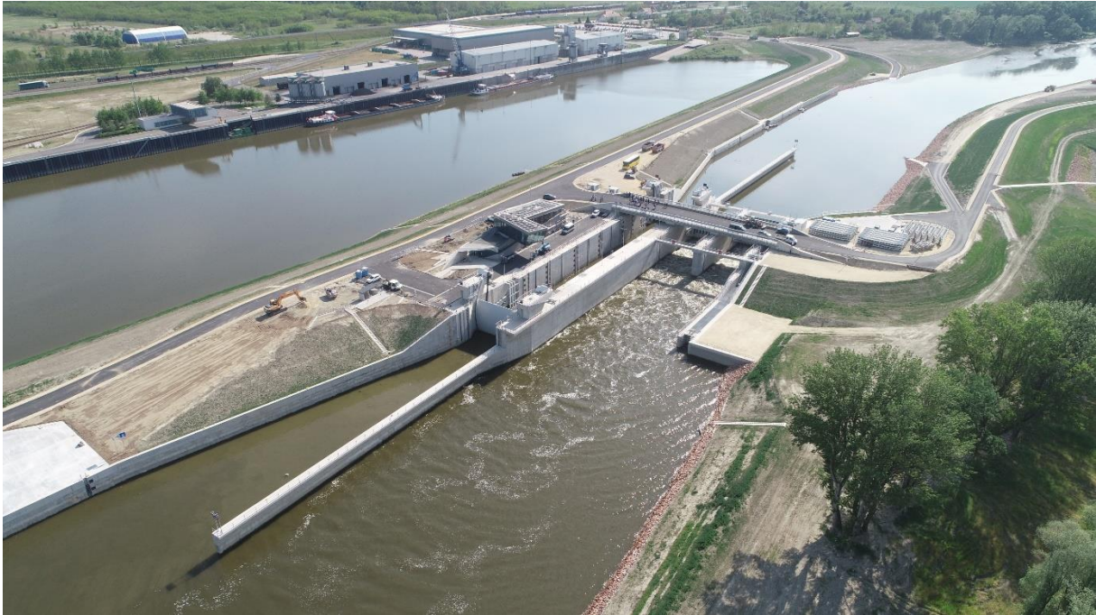
1. fénykép. 2022.05.12-én készített drónfelvétel az alvíz felől
