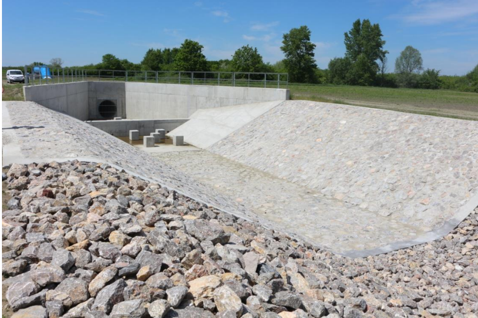
16. kép. Nyomóvezeték belépése a csillapító műtárgyba I.
