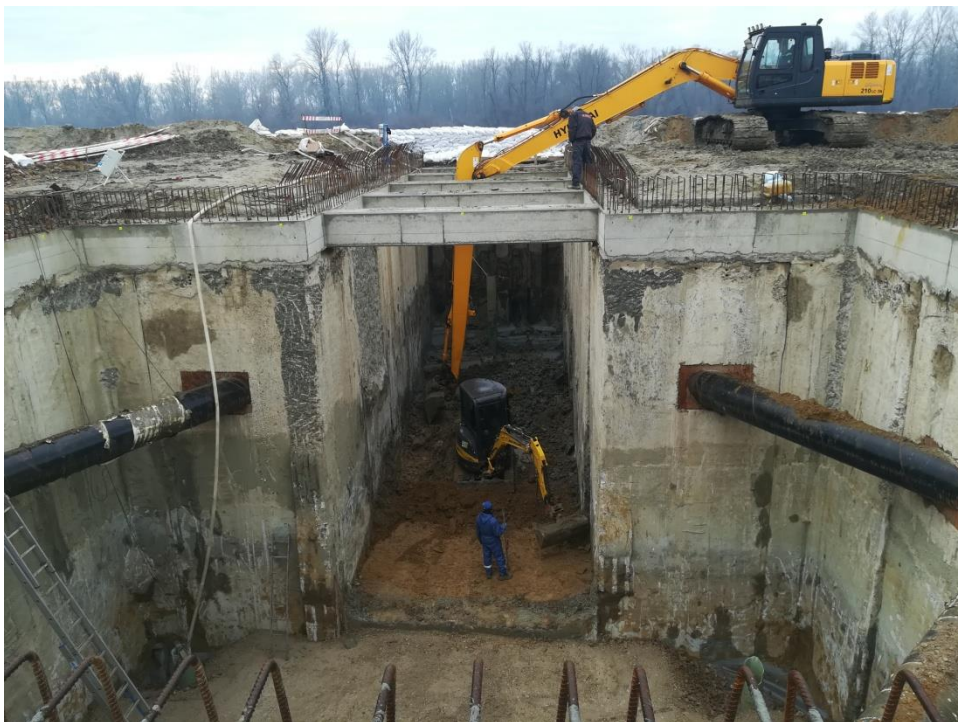
2. kép. Vízkivételi műtárgy építése. Részfalas munkatérhatárolás
