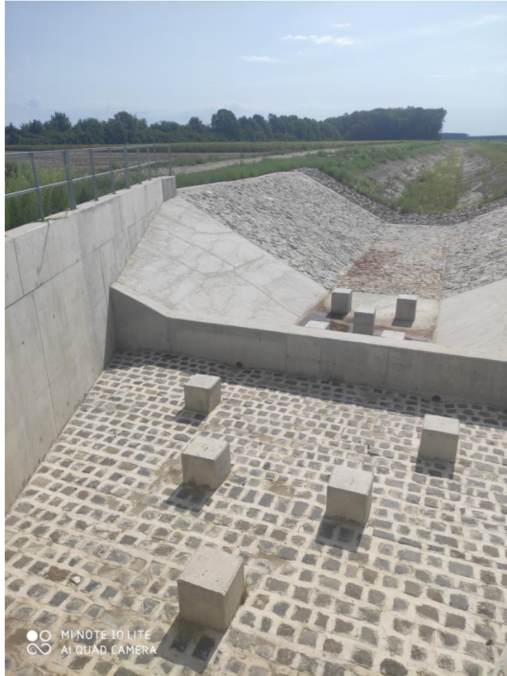
18. kép. Csillapító műtárgy csatlakozása a földárokhoz
