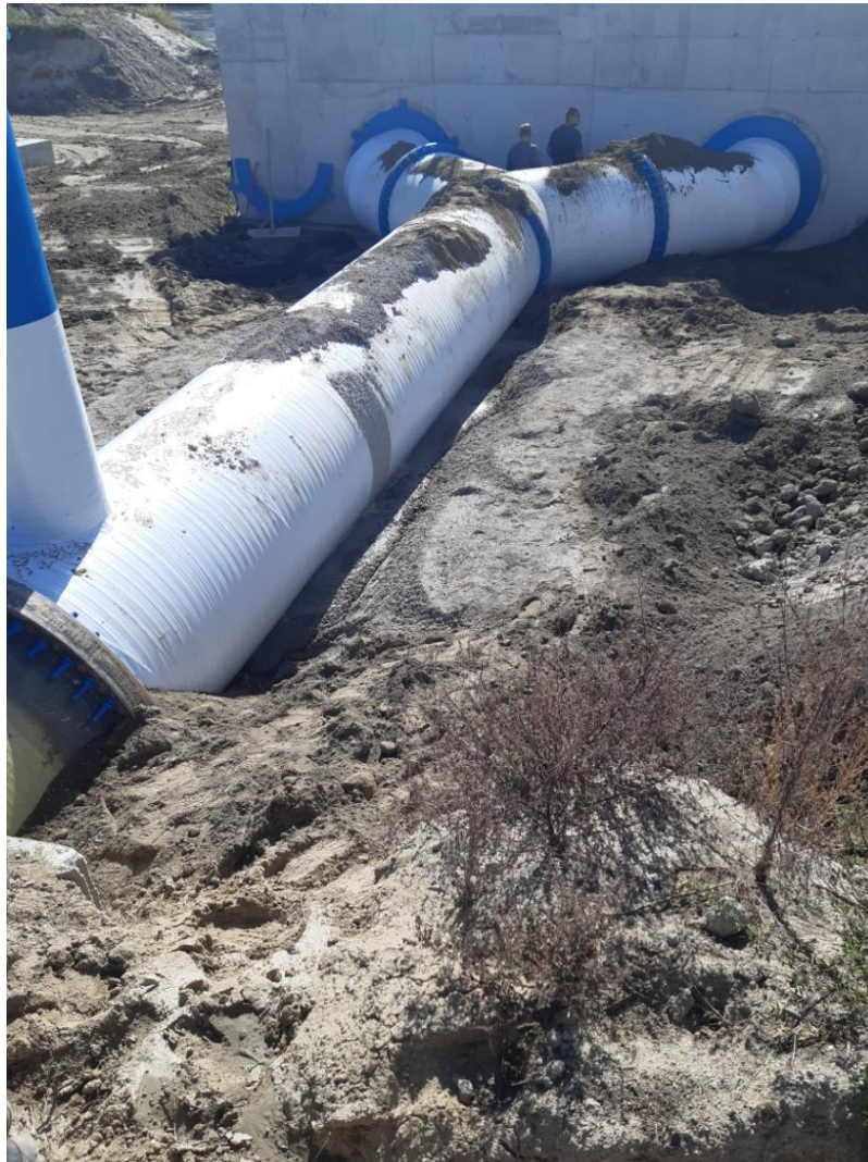
11. kép. Nyomóvezeték kilépése a vízkivételi műtárgyból
