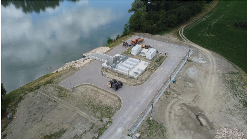
5. kép. Vízkivételi műtárgy madártávlatból
