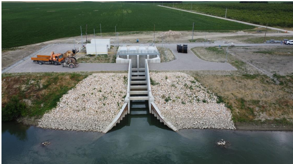
6. kép. Vízkivételi műtárgy a folyó felől
