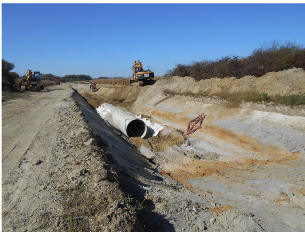
15. kép. Nyomóvezeték építése II.
