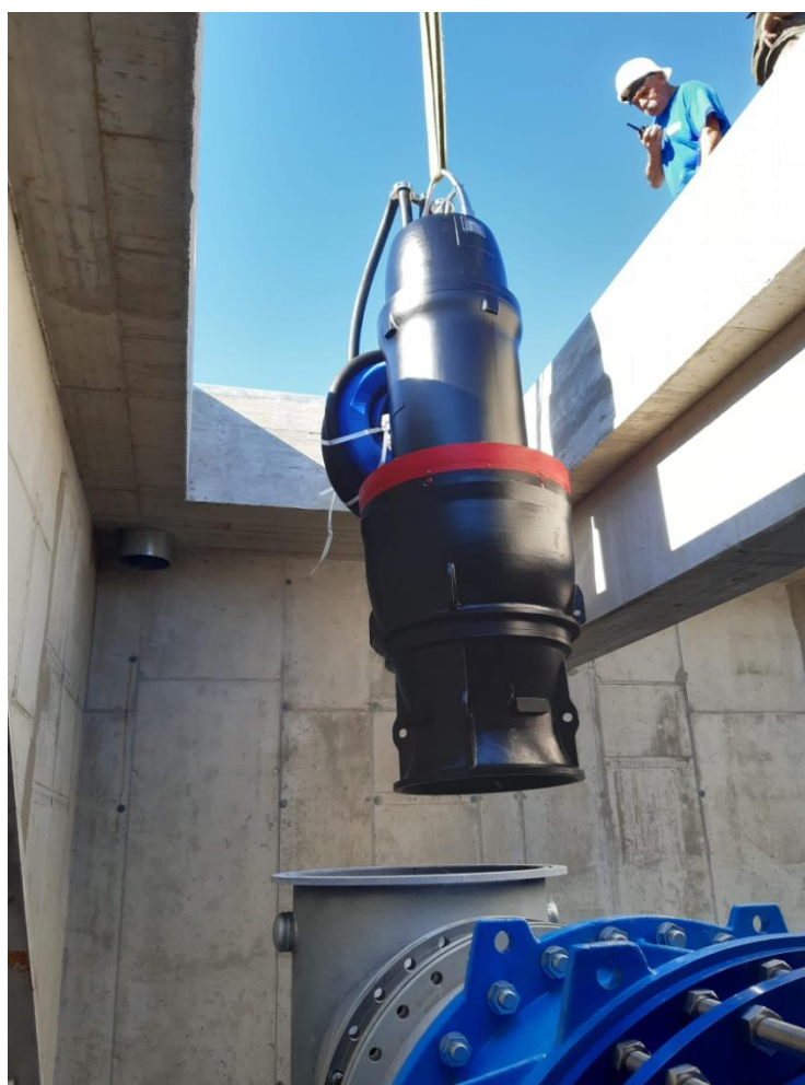
9. kép. Szivattyú beemelése
