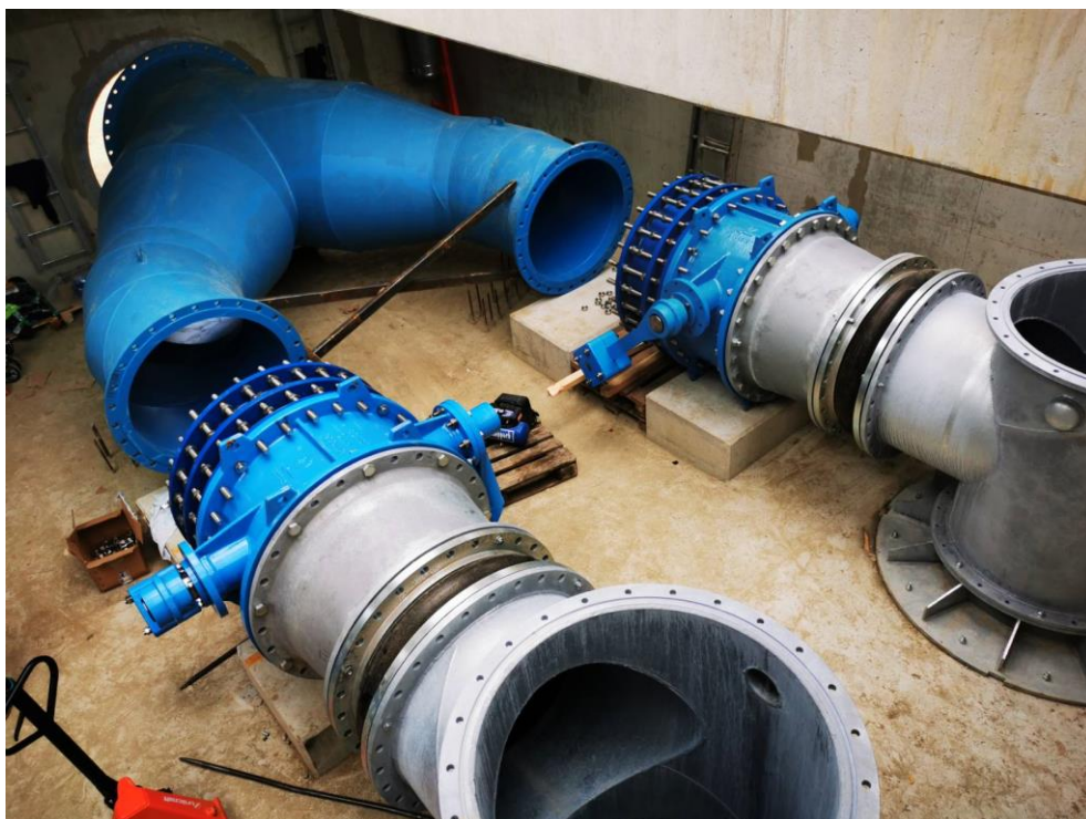
8. kép. Vízkivételi mű. Szerelvénytér építés közben
