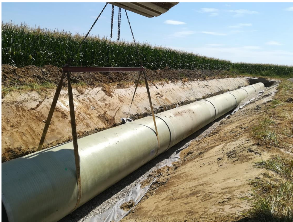
14. kép. Nyomóvezeték építése I.
