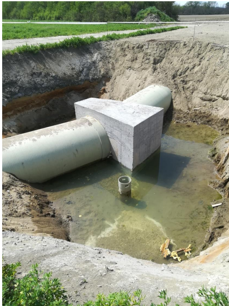
13. kép. Nyomóvezeték töréspontjának megtámasztása
