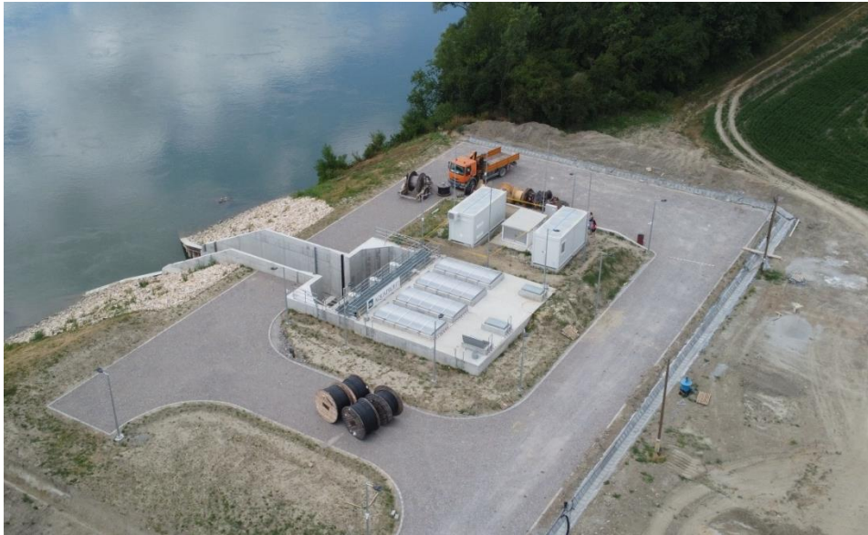
1. kép. Vízkivételi műtárgy madártávlatból
