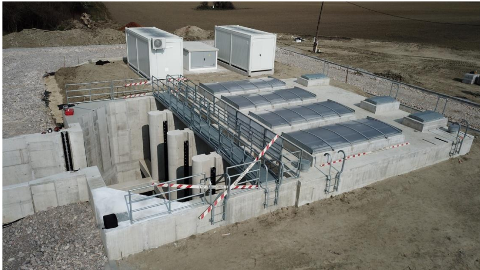
4. kép. Vízkivételi műtárgy. Szerkezetkész állapot
