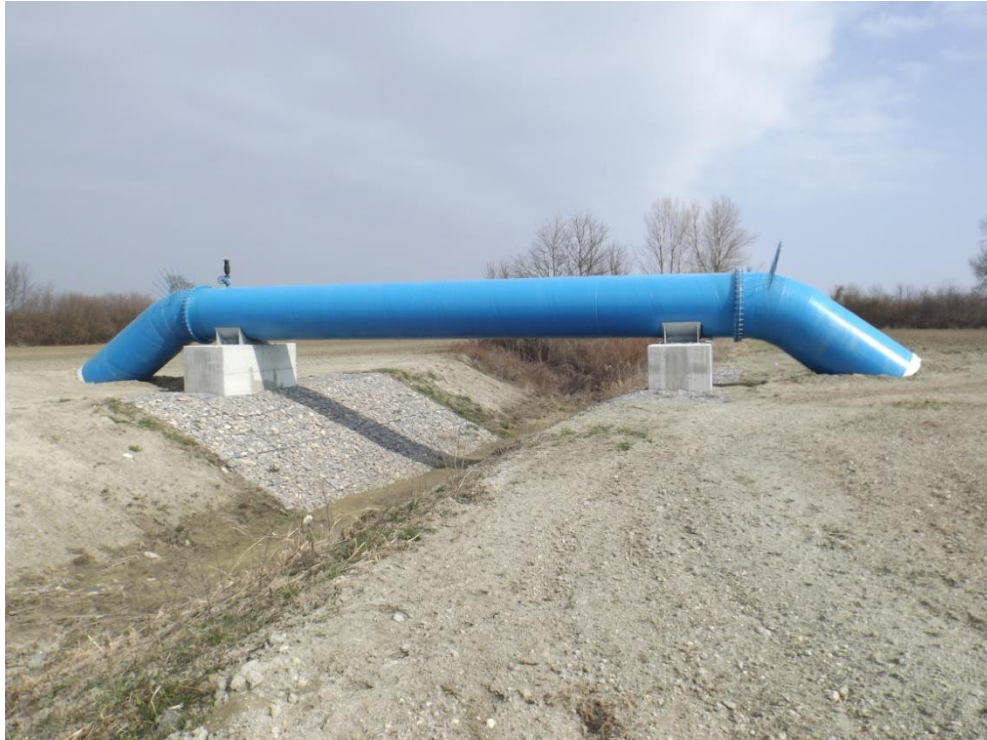
12. kép. Nyomóvezeték, csőhíd
