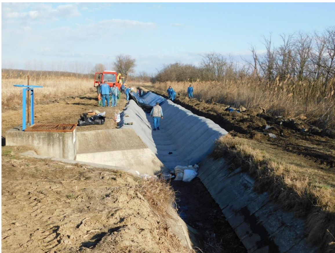
8. kép. Betonpaplan fóliával történő letakarása éjszakai időszakra, hidratálás előtt (saját fotó, 2022)
