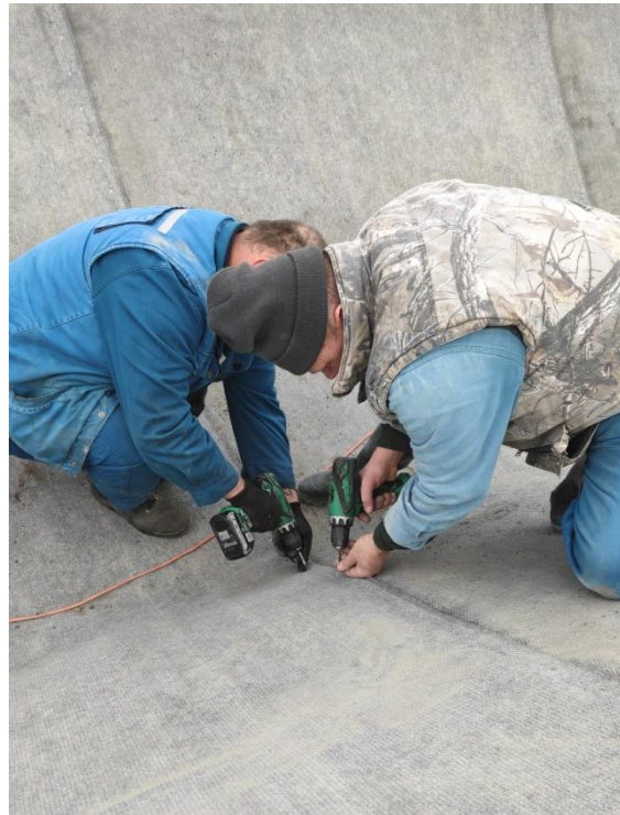
7. kép: Betonpaplan rétegek csavaros rögzítése (saját fotó, 2022)
