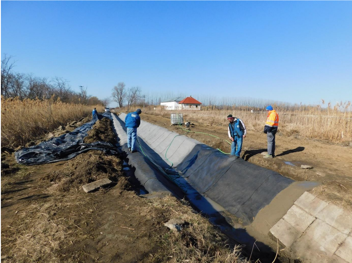
9. kép: Betonpaplan hidratálása (saját fotó, 2022)
