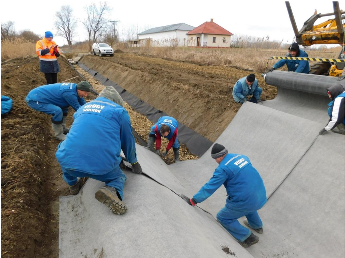
4. kép. CCX betonpaplan elhelyezése, méretre szabása (saját fotó, 2022)
