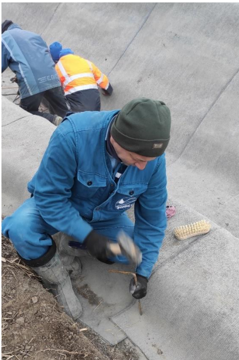
6. kép: Rögzítő cövek leverése (saját fotó, 2022)
