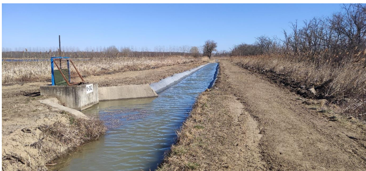
12. kép: A kivitelezés után üzembe helyezett mederszakasz (saját fotó, 2022)
