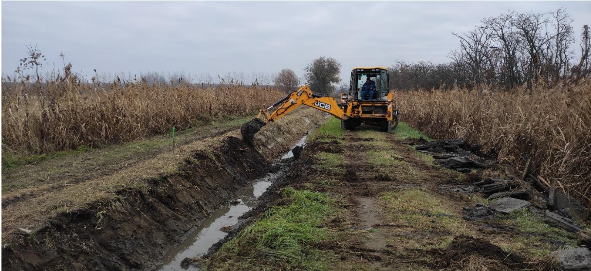
3. kép. A Tiszafüredi II. mellékcsatorna meglévő mederburkolatának elbontása (saját fotó, 2022)
