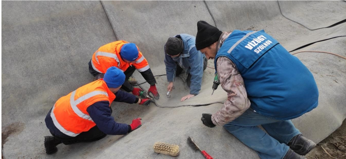
5. kép CCX betonpaplan rétegek hegesztésének bemutatása a Concrete Canvas munkatársai által (saját fotó, 2022)
