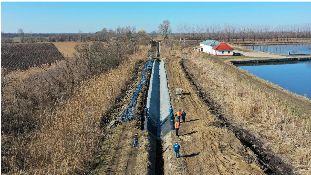
10. kép: Betonpaplan munkaterület madártávlatból, hidratálás közben (fotó: Tóth Gábor, 2022)
