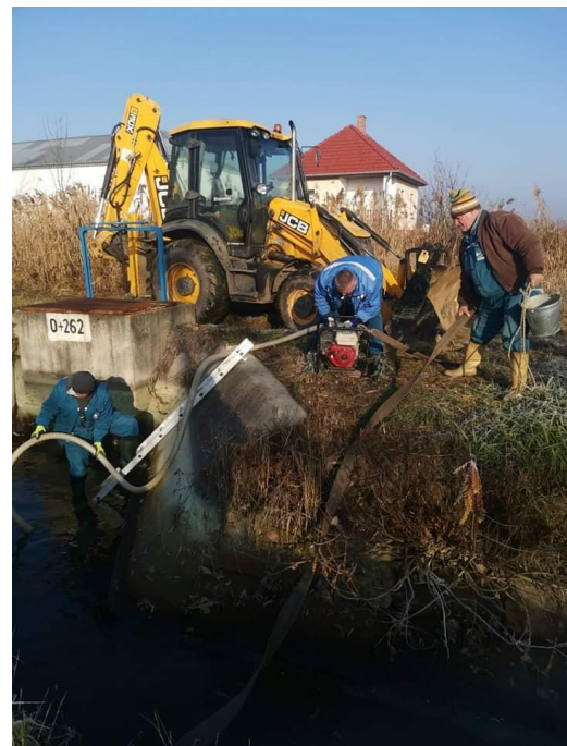
2. kép. Kivitelezéssel érintett mederszakasz víztelenítése csapadék után (saját fotó, 2022)
