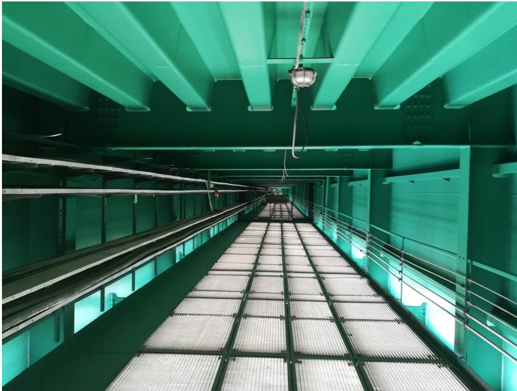
16. kép: A duzzasztómű felett végighúzódó, szekrénytartós szerkezetű üzemi híd acélszerkezetének a korrózióvédelmi munkái
