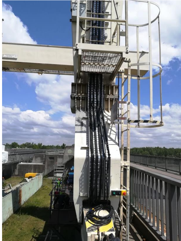
2. kép: A bakdaru elektromos vezetékei, az ideiglenesen lebontott takarólemezek nélkül
