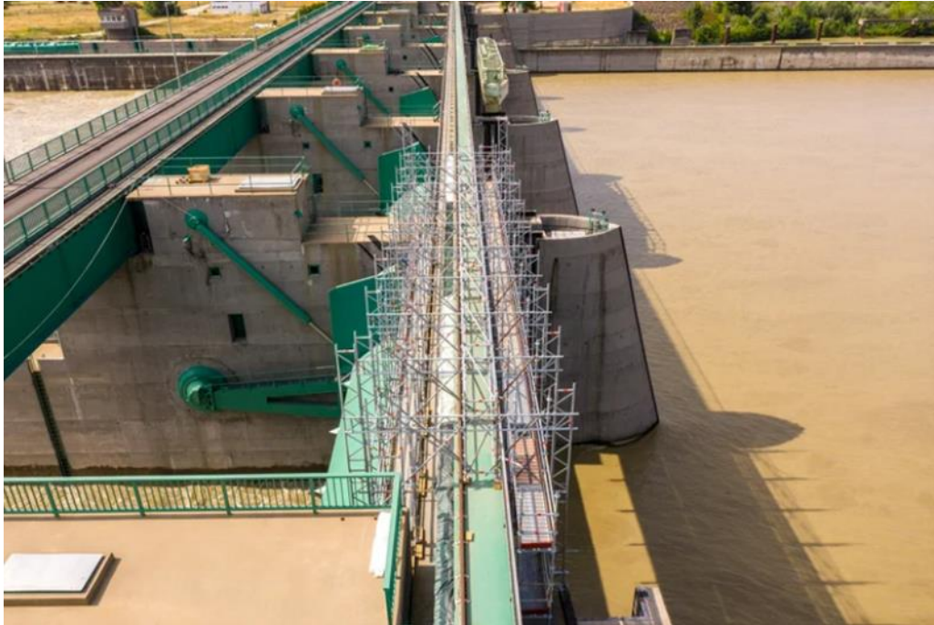
17.b. kép: Dunakiliti duzzasztómű darupálya állványozása a korrózió védelem végzéséhez
