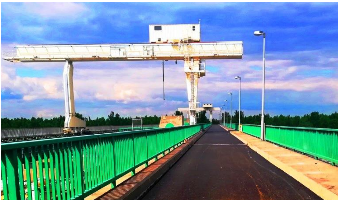
20. kép: 2022.05.31 A Duzzasztómű feletti szekrénytartó új aszfalt réteget kapott.
