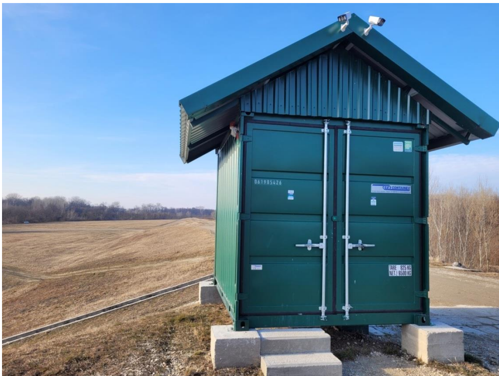
11. kép: A felújított Rajkai 1. számú vízkivételi zsilip irányító konténere, 2022 január 27-én
