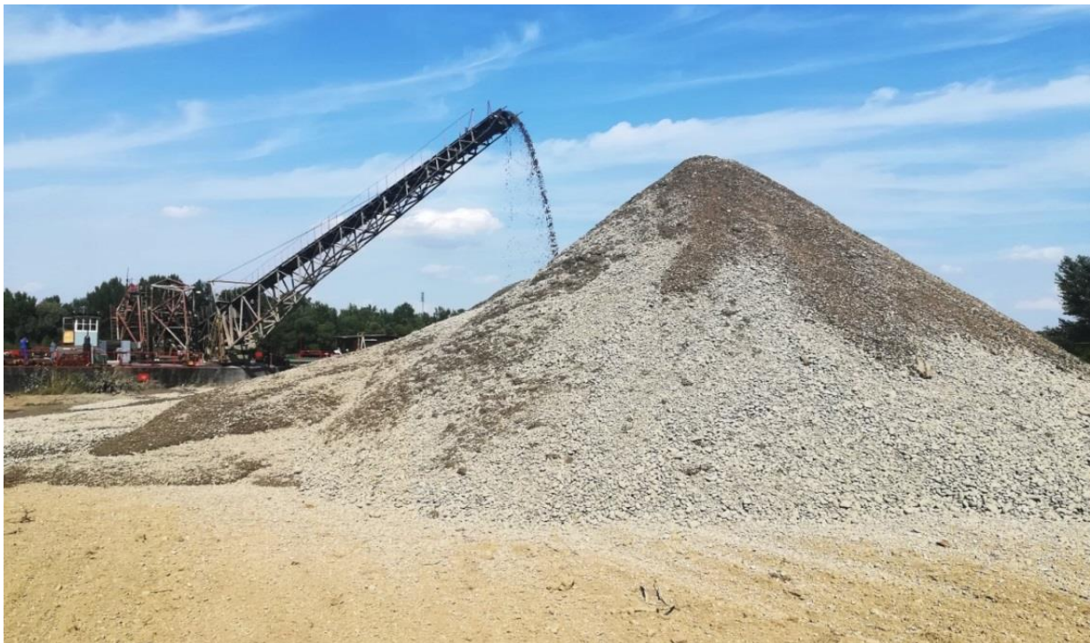
7. kép: Mederkotrásból származó kavics ideiglenes deponálása
