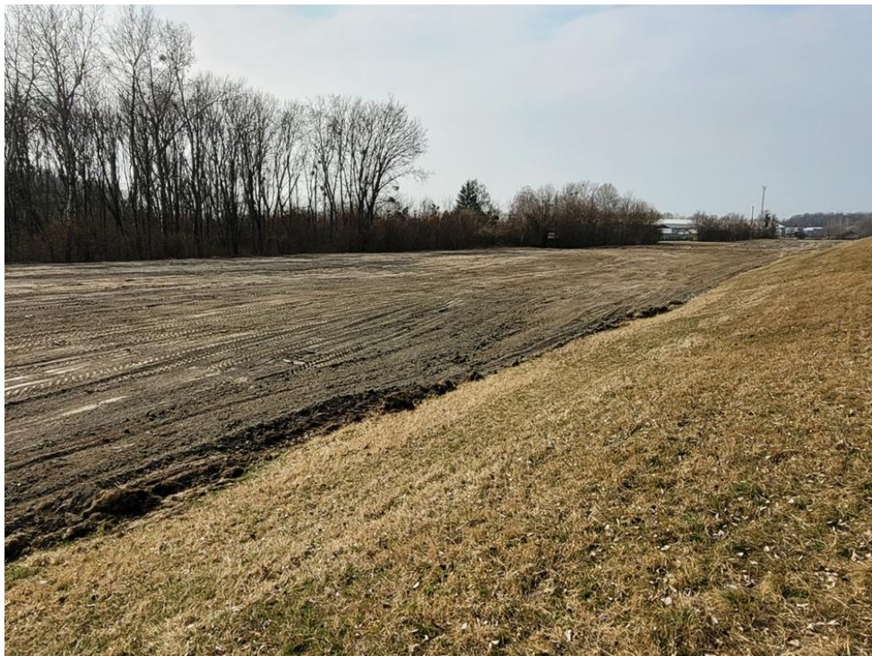
9. kép: Anyaghelyezés, az árvízvédelmi töltés, a mentett oldali figyelősáv erősítése
