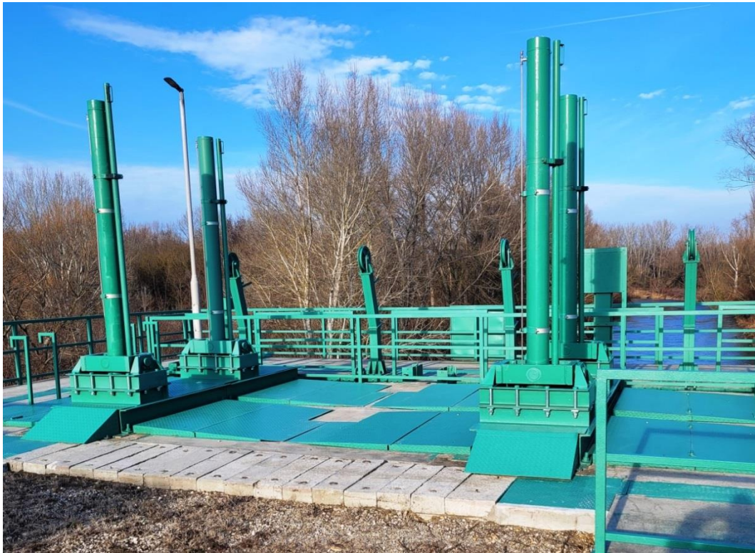
10. kép: A felújított Rajkai 1. számú vízkivételi zsilip felvízi hidraulika szerkezetei
