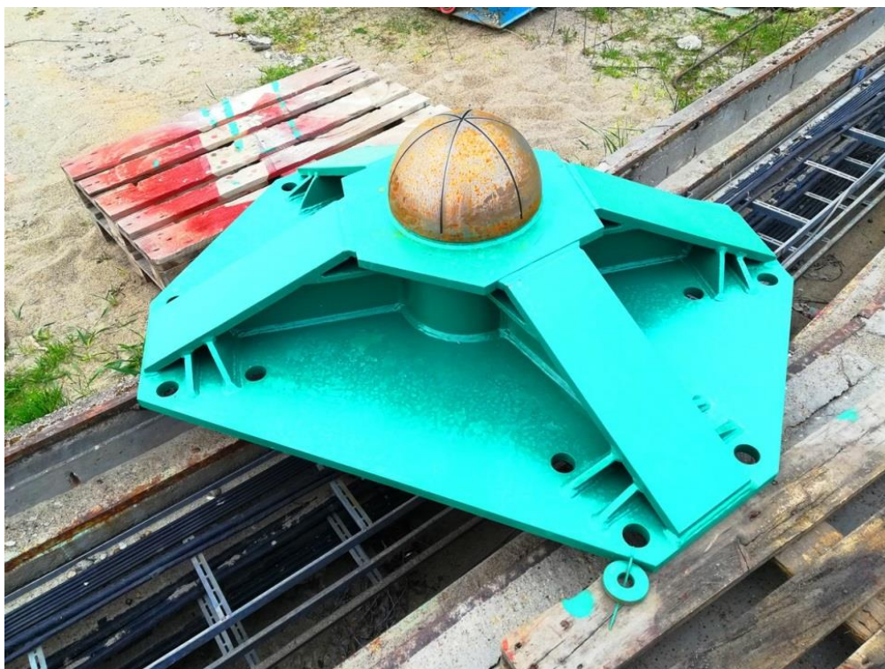
15. kép: 2021.04.02. Dunakiliti duzzasztómű hajózsilip jobb parti támkapu talpcsapágója
