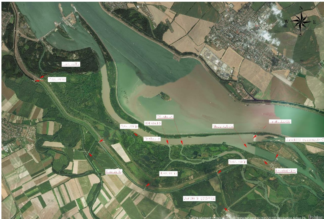
1. kép: A rekonstrukcióval érintett terület
