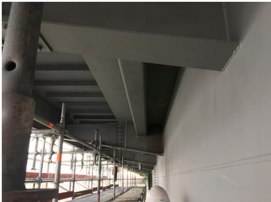
2. kép: Üzemi korrózióvédelmi festési munkái
