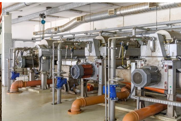
4. kép: Iszapvízt. centrifugák (fotó: Hajdú László)
