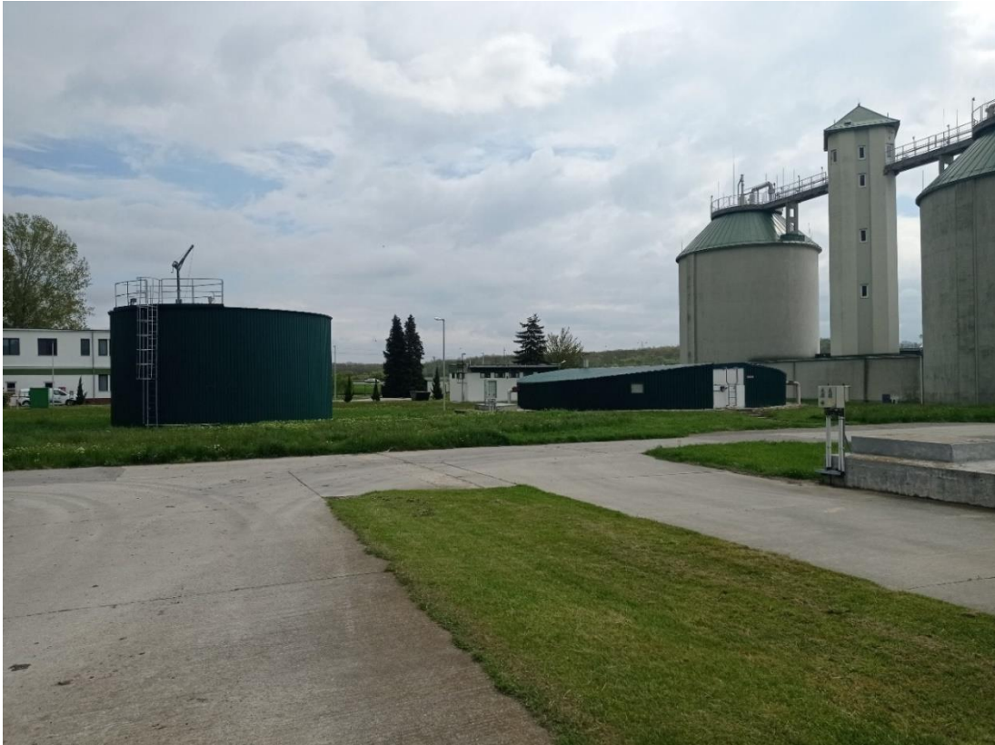
9. kép: Iszaptározó medencék (bővítmény a kiemelt) (fotó: Mészáros Imre)
