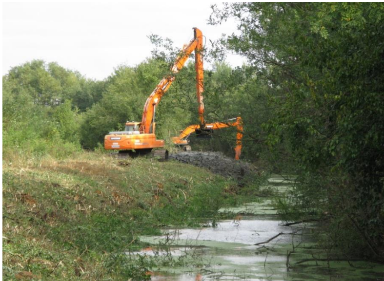
6. ábra: Alsó-Selypes főcsatorna 0+000-3+610 szelvények között
