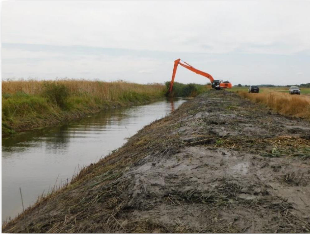
10. ábra: Sárréti-főcsatorna kotrása
