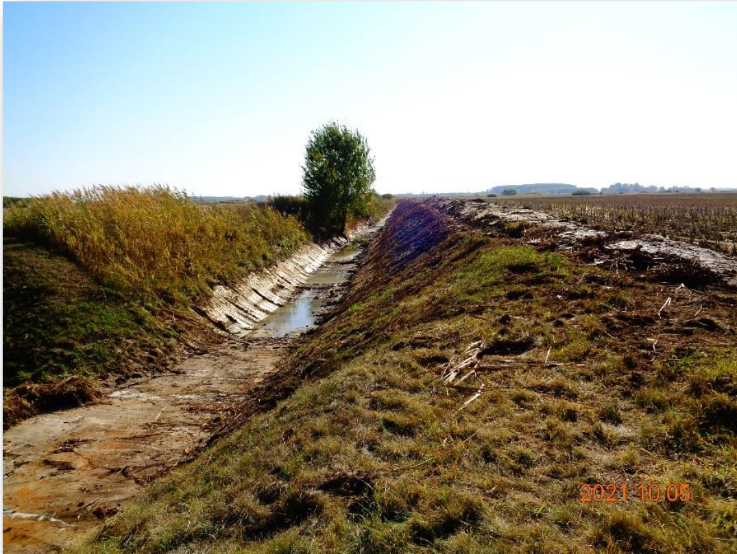
12. ábra: Kődombszigeti-főcsatorna kotrása
