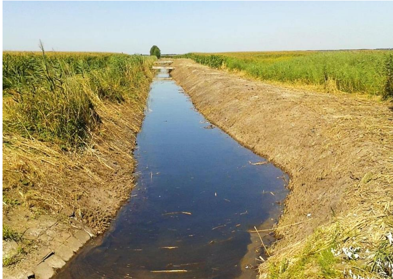
5. ábra: Hamvas-főcsatorna 39+630-41+752 szelvények között
