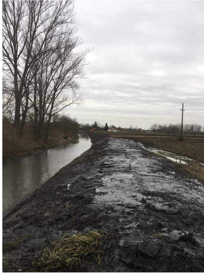
8. ábra: Király-ér csatorna kotrása
