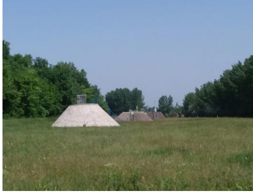
2. kép: A vízbázist termeltető parti szűrészű csókutak (Baki Zoltán, BÁCSVÍZ Zrt., 2018.)
