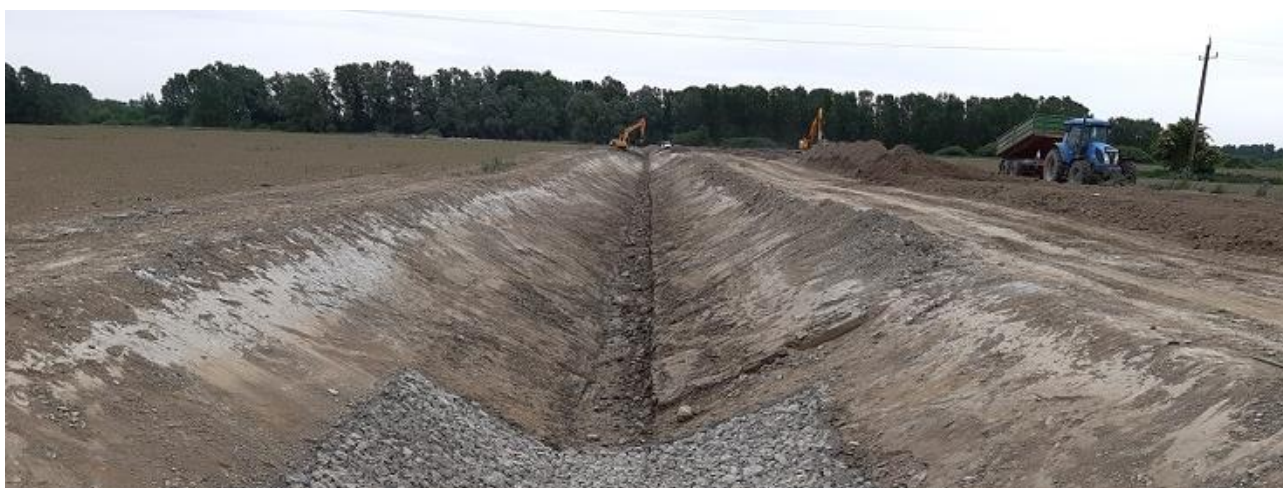
20. kép. Mailáthpusztai tápcsatorna építési munkái
