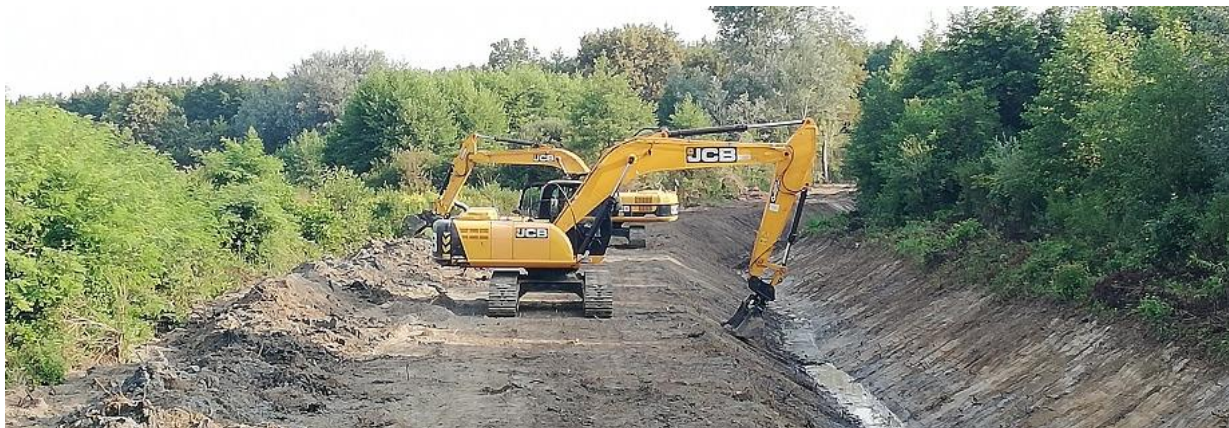
19. kép. Zehipusztá-Kemsei árok mederkozási munkái
