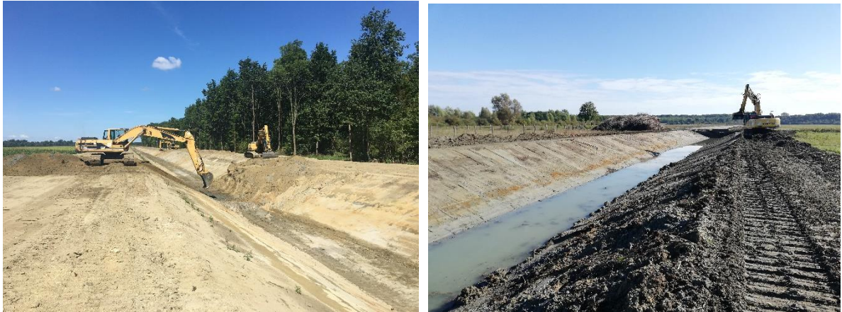
6. kép. Főcsatorna építés munkái
