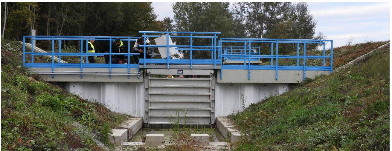
18. kép. Kápolnai-Gürü csatorna 36a jelű duzzasztó műtárgy
