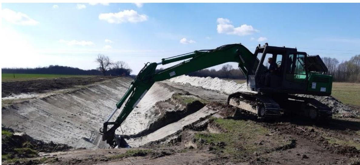
14. kép. Korcsina-Bisztrica összekötő árok építése
