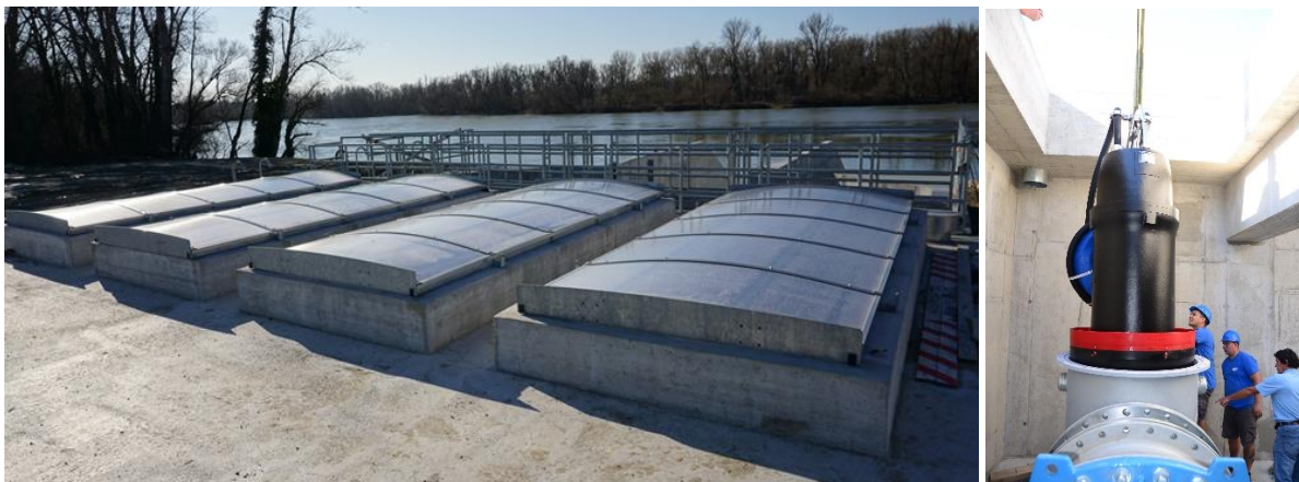
3. kép. Gépleadó nyílások a gépház tetején és a szivattyú beépítése
