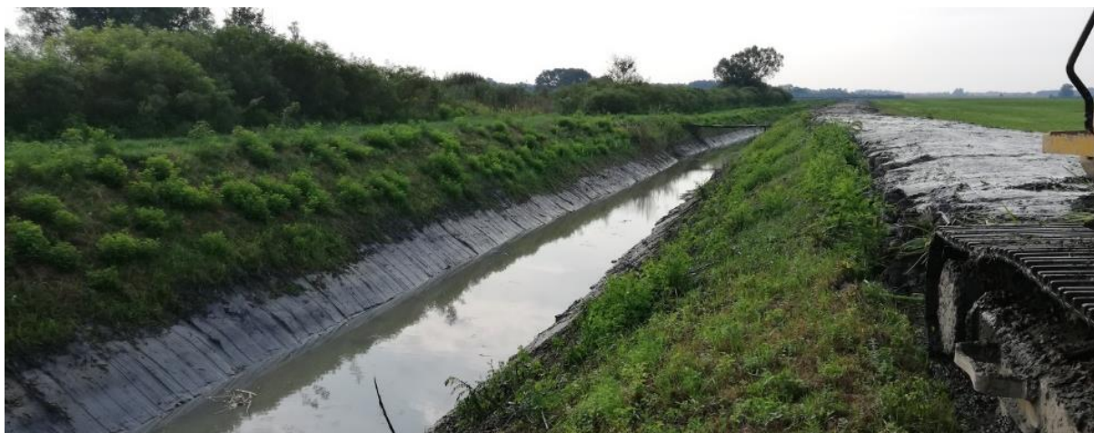
13. kép. Mederkotrásai munkák a Korcsina-csatornán
