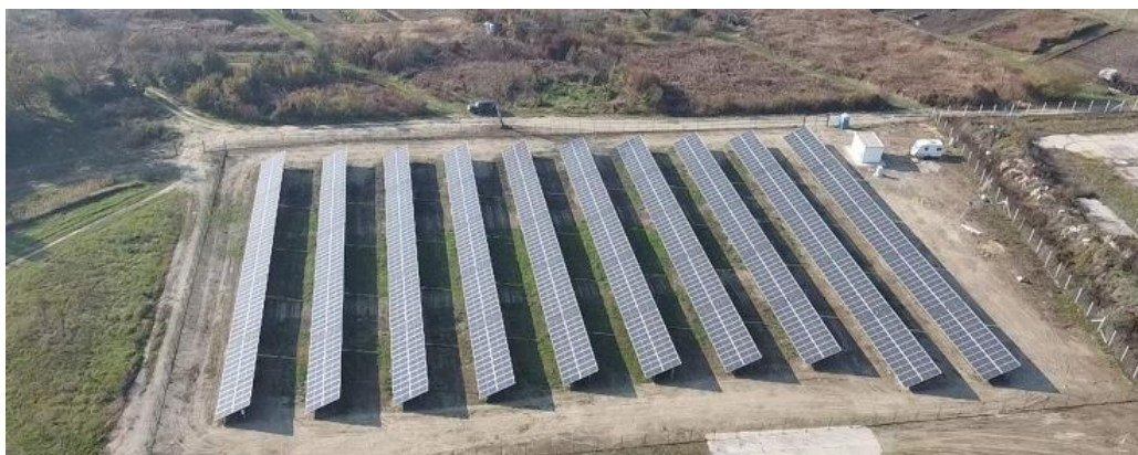
24. kép. A megépült naperőmű
