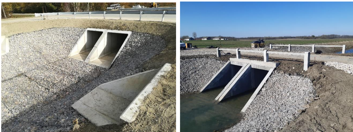
11. kép. Főcsatorna S3 és S5 jelű áttereszek
