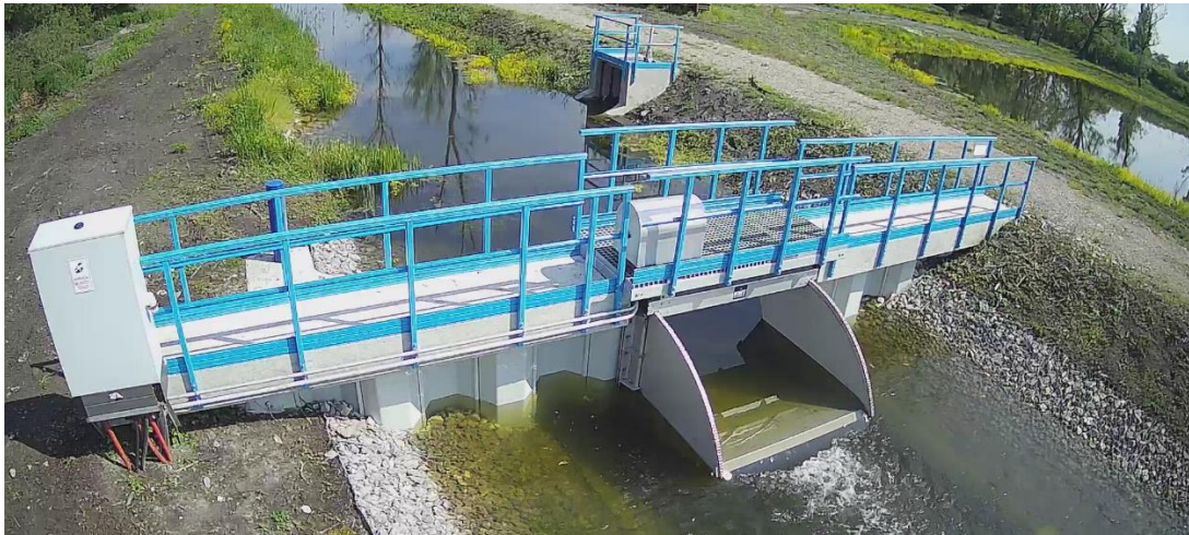
27. kép. A távvezérelt Sellyei-Gürü csatorna U4 jelű duzzasztó műtárgy a webkamera képe
