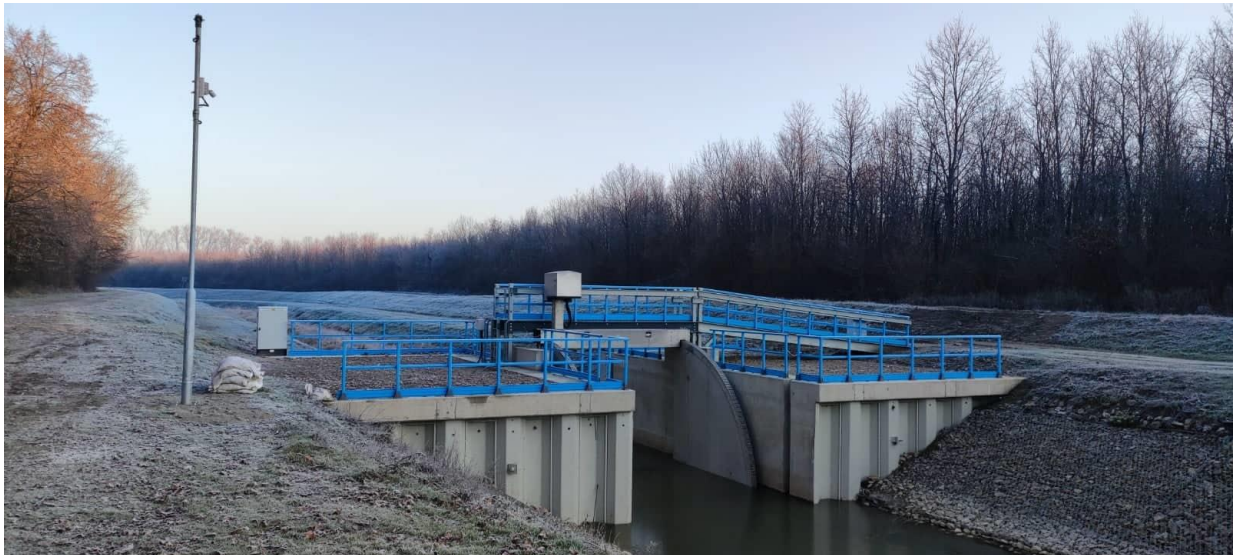
15. kép. 3. jelű duzzasztó műtárgy a Korcsina-csatornán
