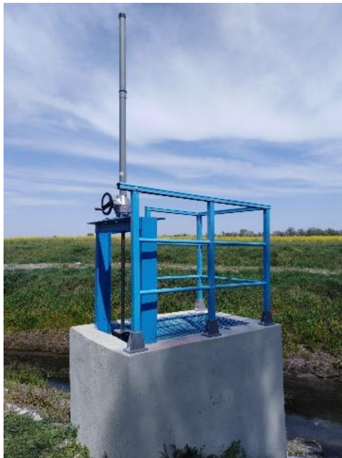
16. kép. Felújított oldalműtárgyak a Korcsina-csatornán
