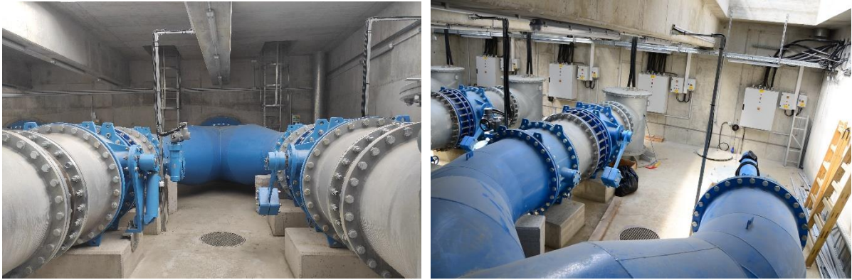
4. kép. Nyomóágak a gépházban
