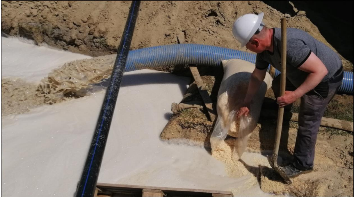
4. fénykép: Gyaluforgács adagolása az iszapvesztés csökkentése miatt A fúrószap gyűrűstérbe vezetésekor adagolják a forgácsot. A háttérben a kifúrt anyagot a fúrószáron keresztül felszínre hozó fúrószap kifolyása látszik
