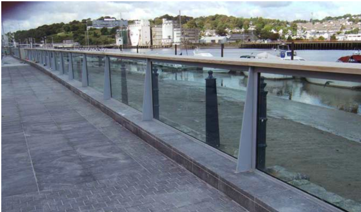
2. kép Üveg árvízvédelmi fal
