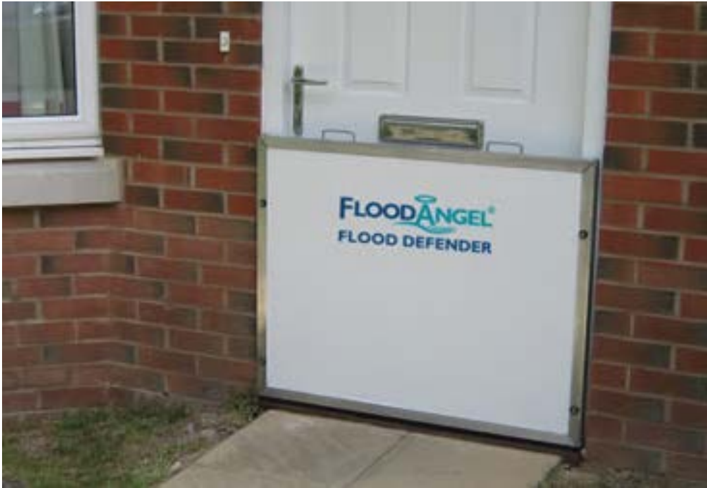
10. kép Lokális árvízvédelmi megoldás Angliában
