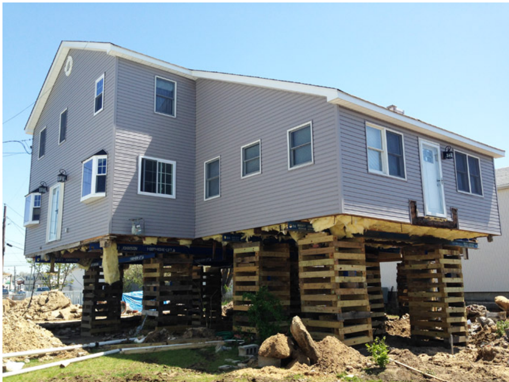
11. kép Épület kiemelése az árvízszint fölé (egyedi megoldás)
