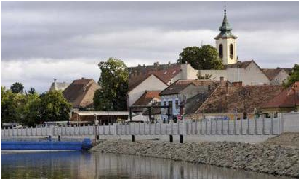
3. kép Mobil árvízvédelmi fal Szentendrén
