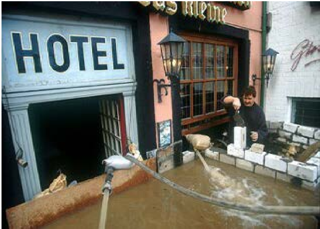
6. kép Lokális árvízvédelem magasítása a Duna mellett Ausztriában
