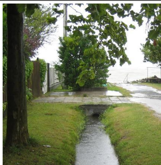
14. fénykép. Nagyobb eső után több hétig áll a víz ebben az árokban
