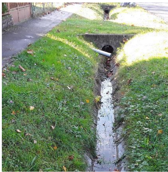
13. fénykép. Árok házi ereszcatorna-bevezetéssel
