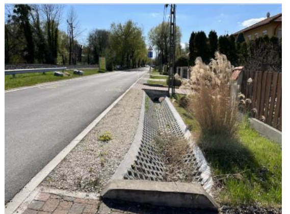
21. fénykép. Elegáns betonárkok, ami később megszűnik
