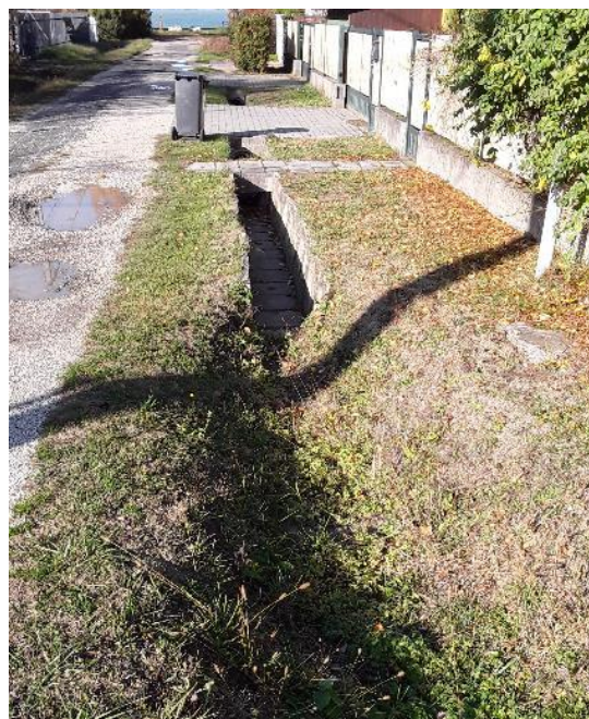
6. fénykép. Különböző árokkialakítás egy kis keresztútcában
