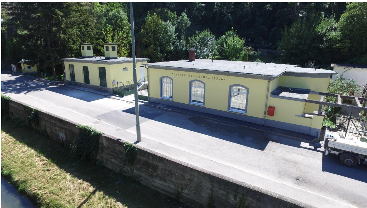
1. fénykép. A Víziközmű Múzeumnak otthont adó, felújított 125 éves vízműgépház
