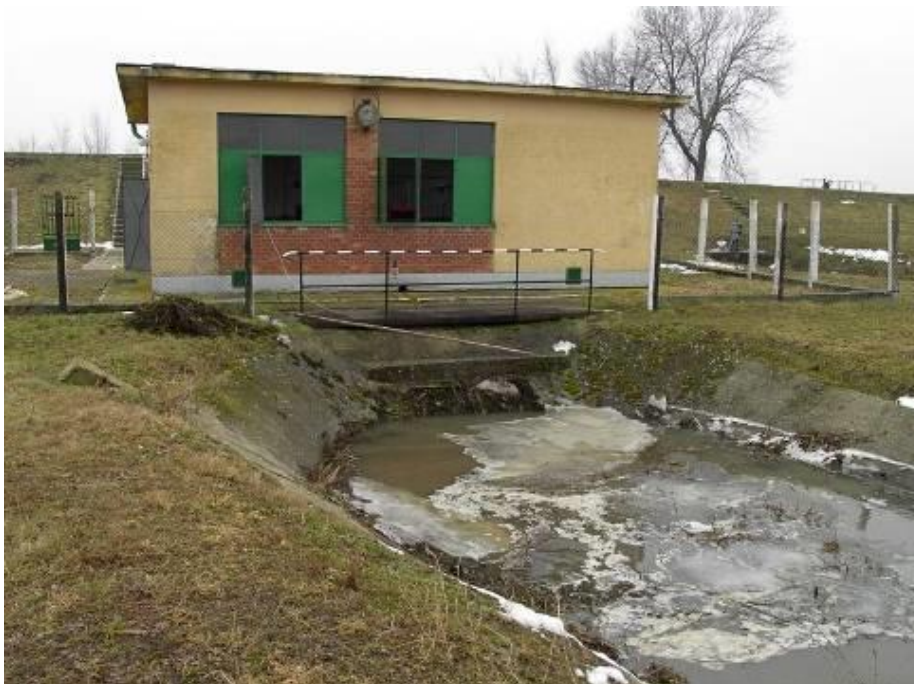
2.ábra: A meglévő Gástyási II. szivattyútelep
