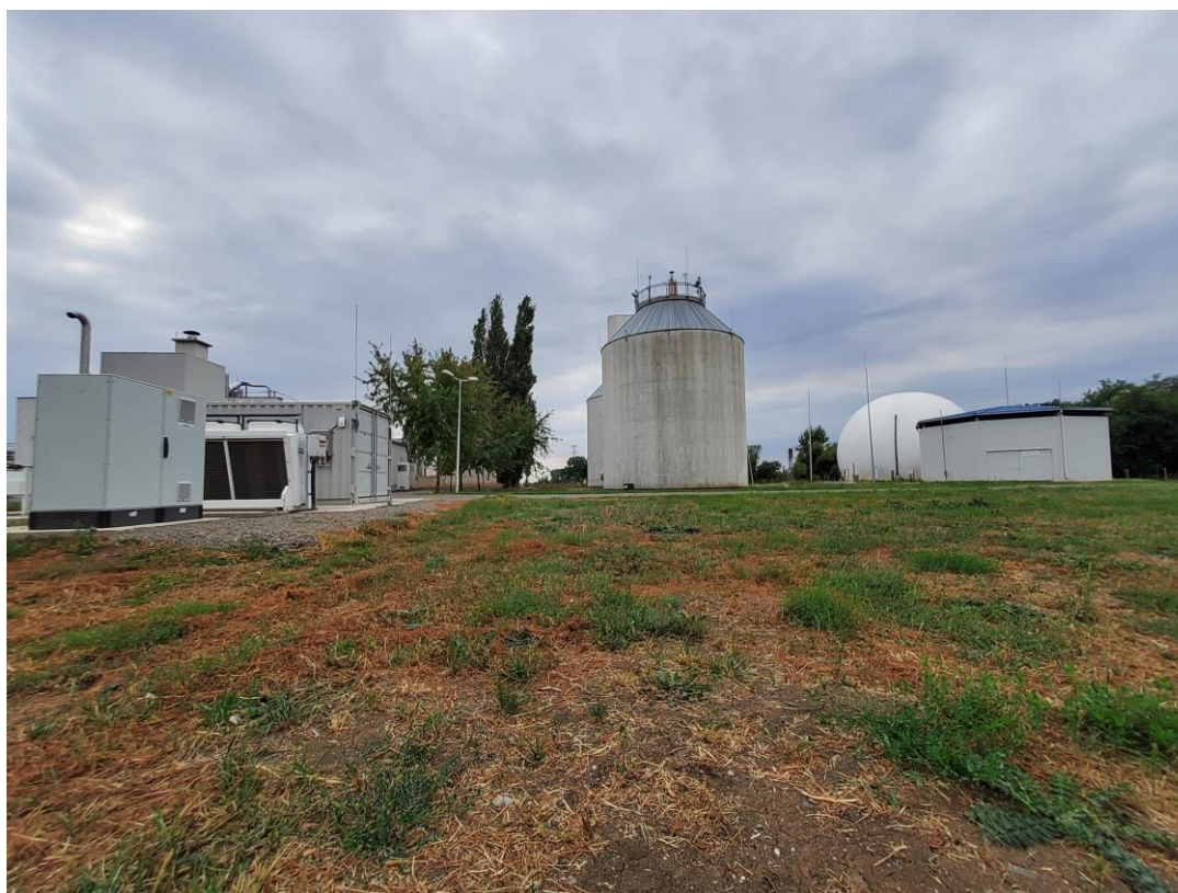
3. ábra. Gyöngyösi rothasztók, gázmotor konténerház
