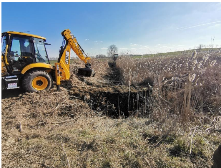
2. fotó: JCB 3CX kotró-rakodógép - Góitói 2-1. csatorna áttöltés (2023.02.06.)
