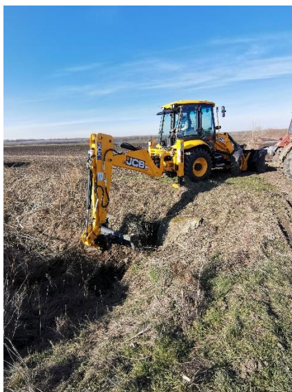
4. fotó: JCB 3CX kotró-rakodógép - átereszkotrás (2023.02.08.)
