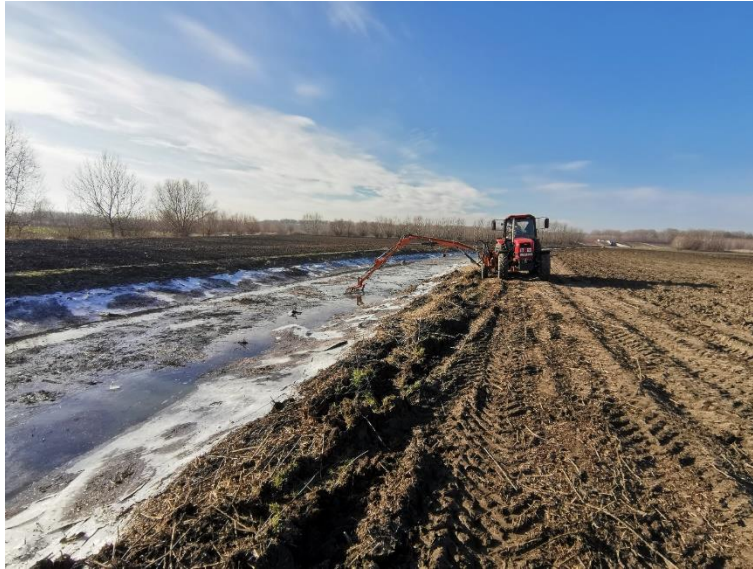
3. fotó: MTZ 1025 (Hidrot) - Vízínövényzet eltávolítása és jég feltörése (2023.02.07.)
