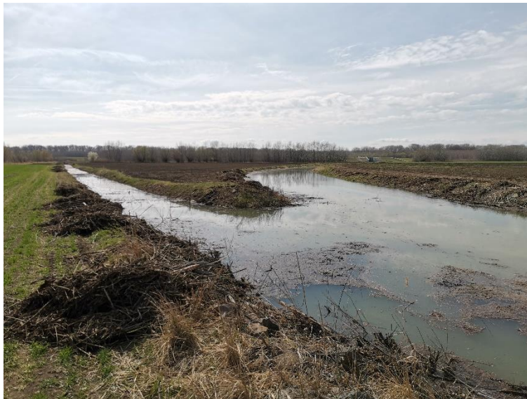
10. fotó: Vezér csatorna és Gó-i-tói 2 mellékcatorna (2023.03.22)
