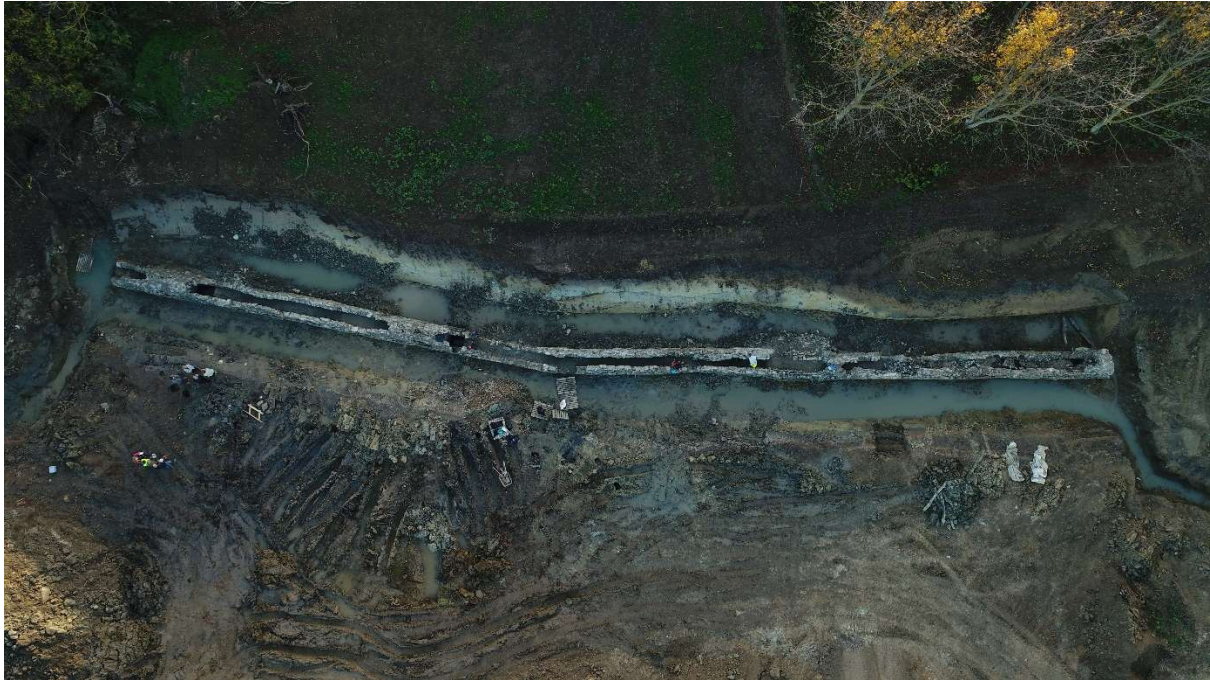
8. ábra: A Savaria vízvezeték tervezett völgyzárógát alatt feltárt szakasza
