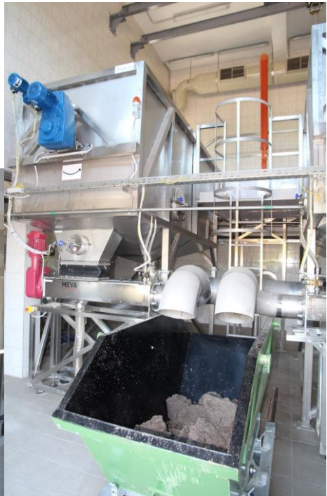
2-3. fénykép. A mechanikai tisztítás berendezései: balra: léptető-rács jobbra: forgó-dobszűrő
