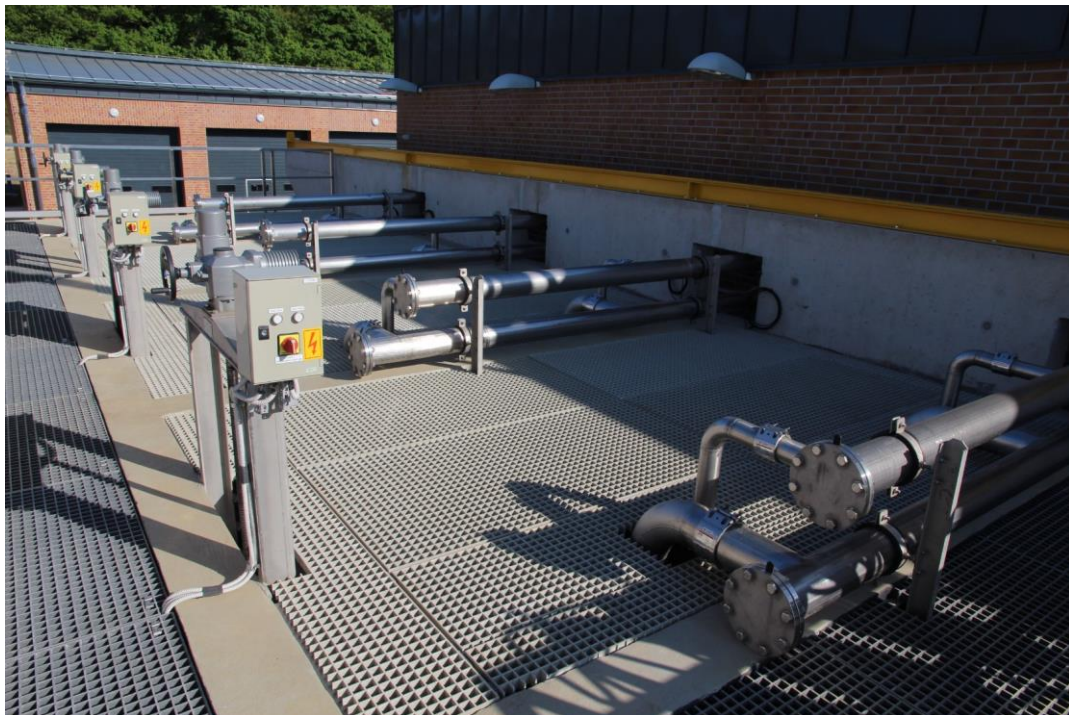
6. fénykép. Az MBR membrán medencéi – LEAP levegőztetéssel
