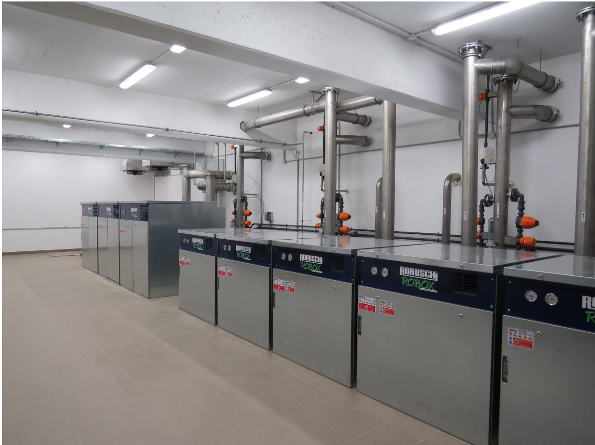
7 – 8. fénykép. Membrán gépészet: balra: szivattyúház jobbra: biológiai és membrán fűvók
