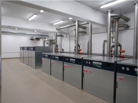
7 – 8. fénykép. Membrán gépészet: balra: szivattyúház jobbra: biológiai és membrán fűvók
