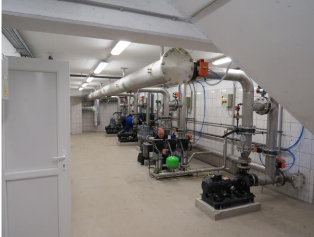
7 – 8. fénykép. Membrán gépészet: balra: szivattyúház jobbra: biológiai és membrán fűvók
