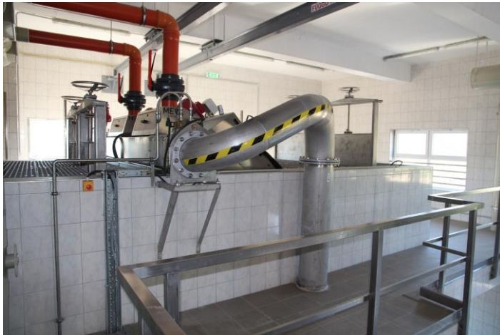
2-3. fénykép. A mechanikai tisztítás berendezései: balra: léptető-rács jobbra: forgó-dobszűrő
