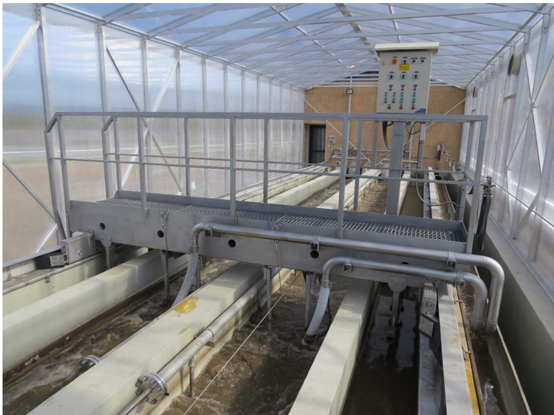
2-3. fénykép. A mechanikai tisztítás berendezései: balra: léptető-rács jobbra: forgó-dobszűrő
