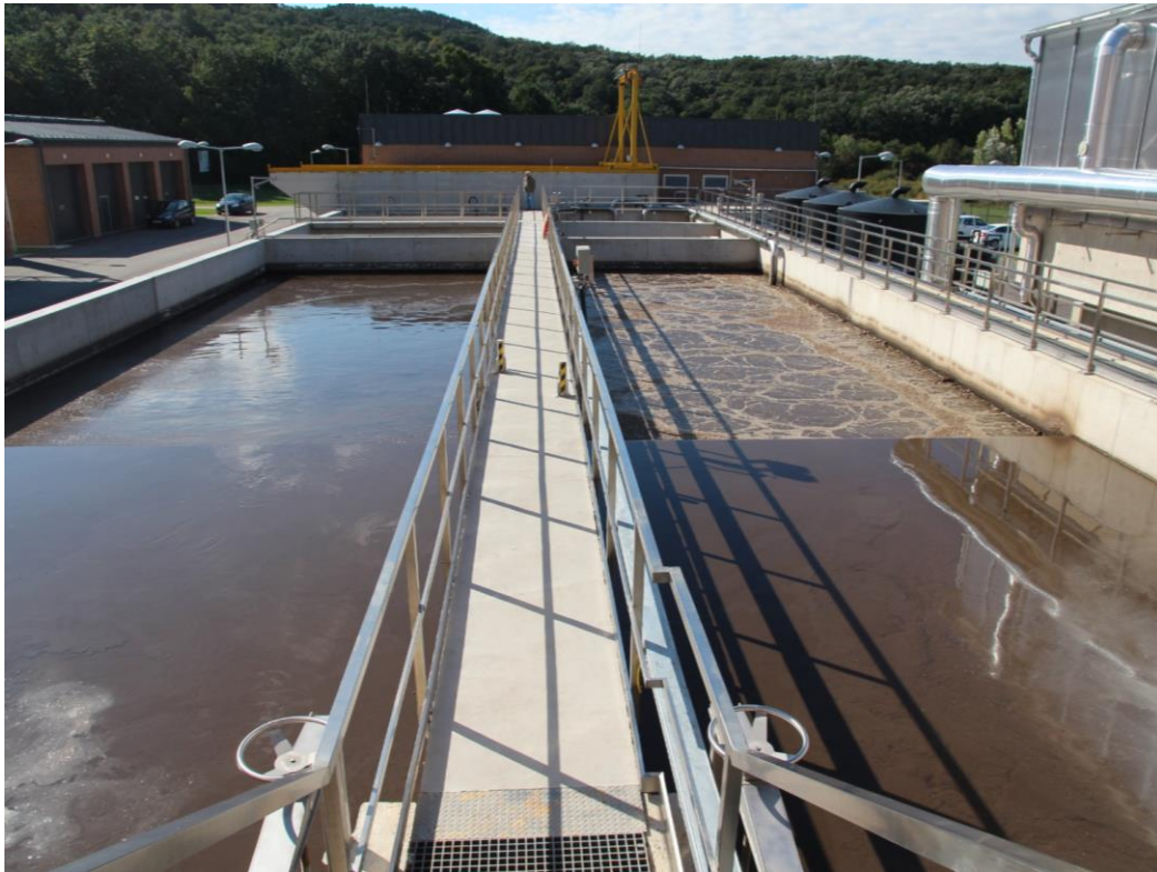
5. fénykép. Biológiai anoxikus medencék és aerob medencék levegőztetés szabályozással
